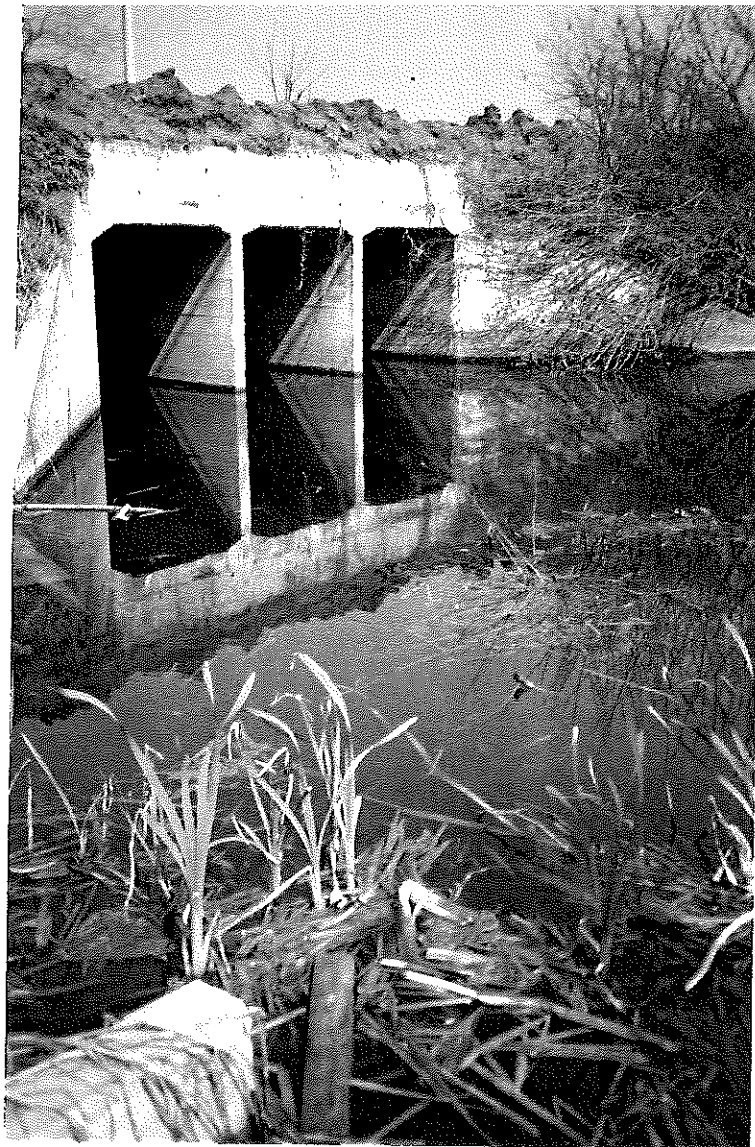
Foto 1: Vista de la obra de descarga y alcantarilla
