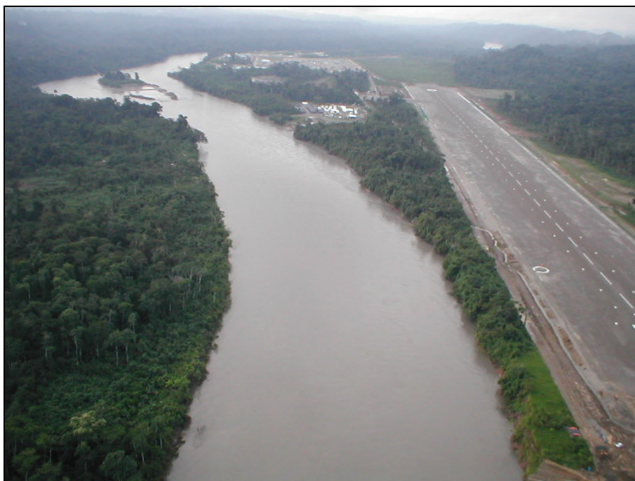
Figura 1.7 Ruta expuesta a los efectos de la erosión.
