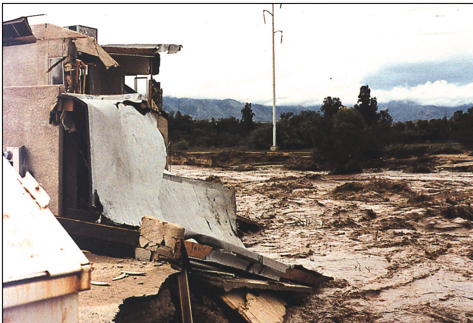
Figura 1.3 Vivienda derrumbada a causa de la erosión de márgenes.
