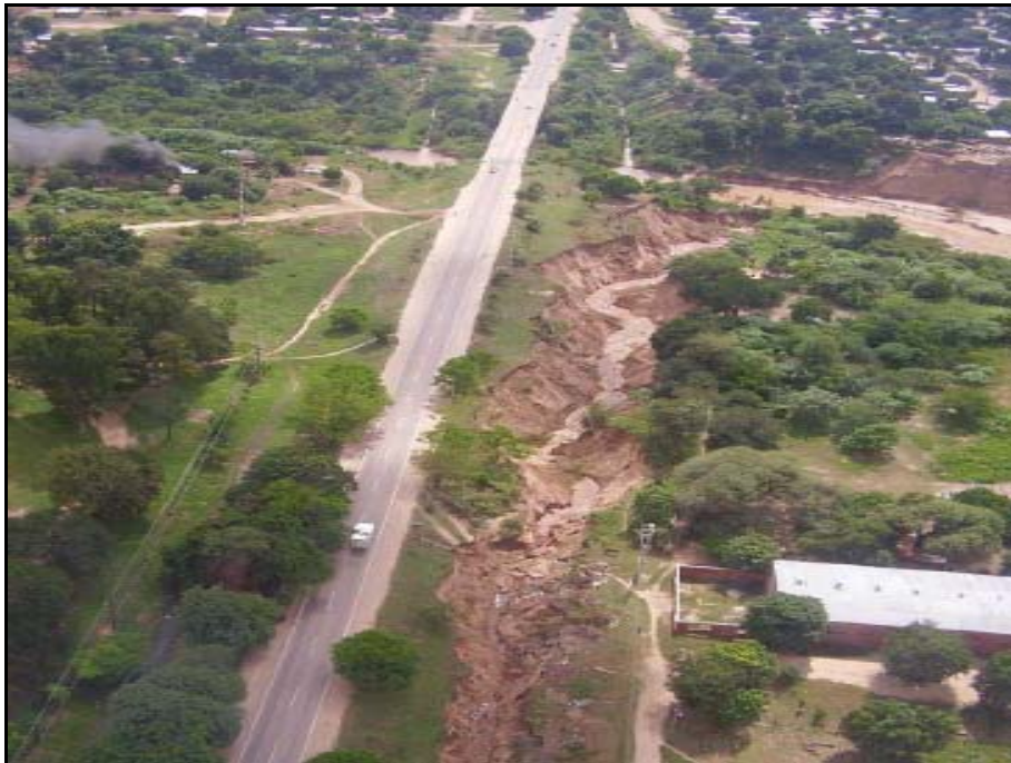
Figura 1.9 Carretera parcialmente afectada.
