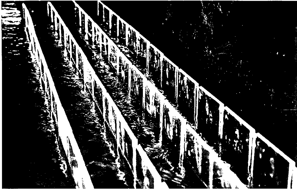
FOTO Nº 3-VISTA DE LAS PERTURBACIONES SUPERFICIALES EN EL CANAL DE ENSAYO DEL ARROYO MALDONADO.(2182-31).
