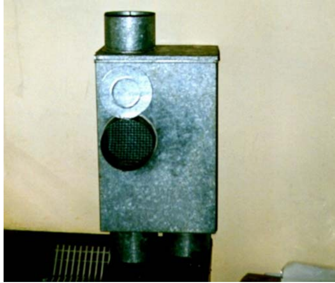
Foto N° 4: Dispositivo regulador domiciliario para bajada de techos
