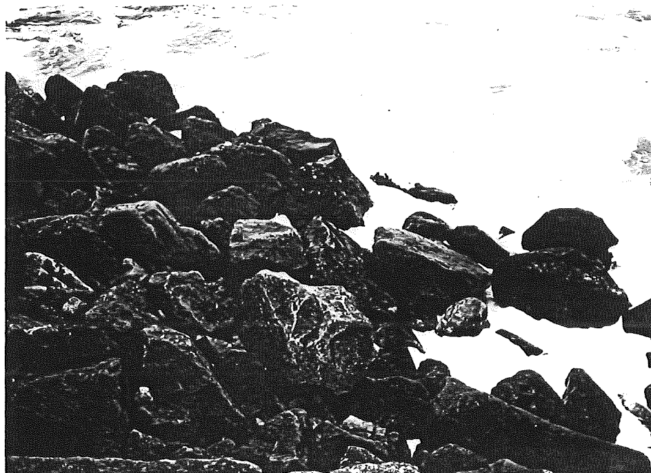
Fotografía Nº 2. 8 de mayo de 1992. Enrocado acumulado sobre el costado interior del morro de la escollera Sur. Se observa la diversidad de tamaños y tipos de roca utilizada.
