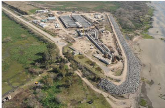
Figura 3.3. Planta de Pretratamiento de líquidos cloacales "Del Bicentenario", Berazategui (foto: www.aysa.com.ar ).
