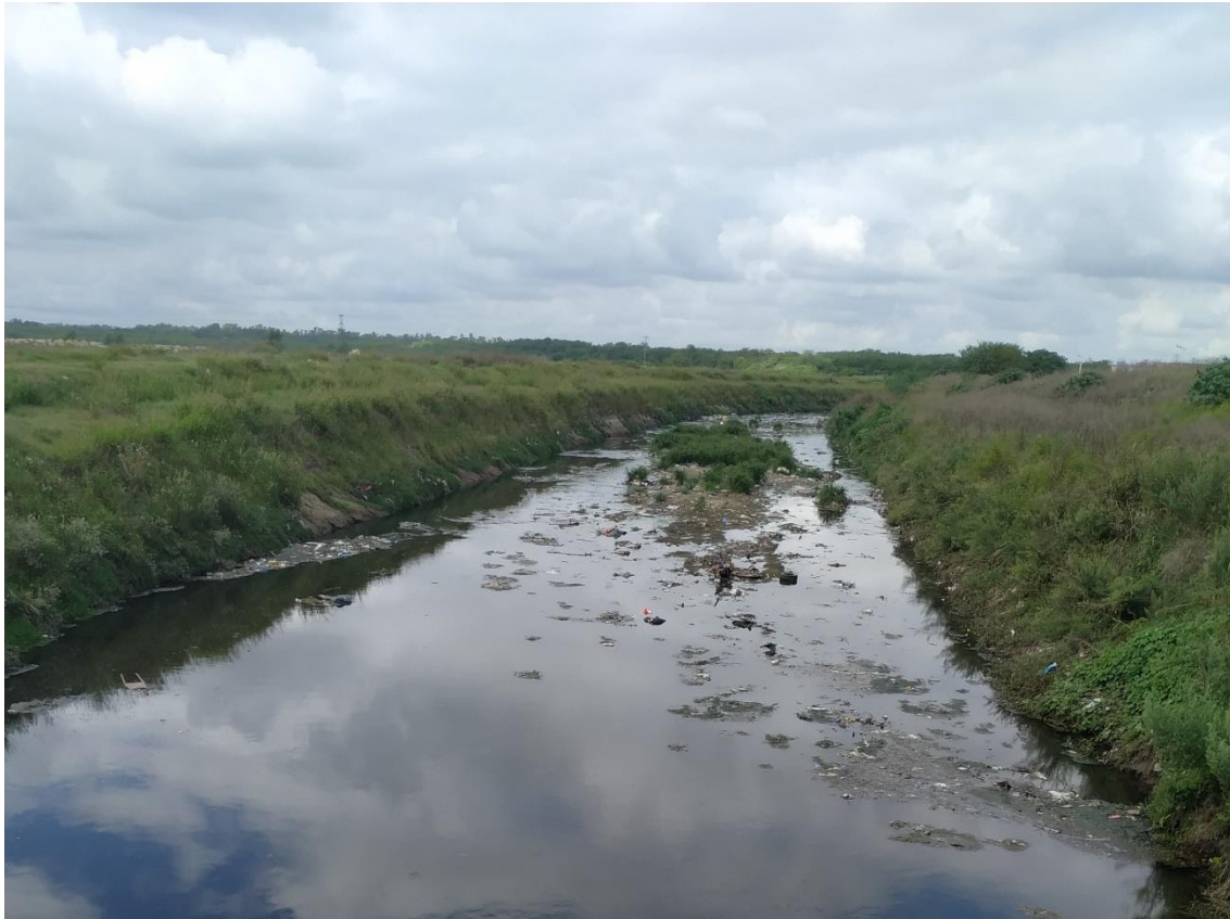
Figura A.37. Vista del A° Don Mario aguas abajo del puente vial de la calle Guillermo Marconi. Se observa fuerte presencia de residuos sólidos flotantes.
