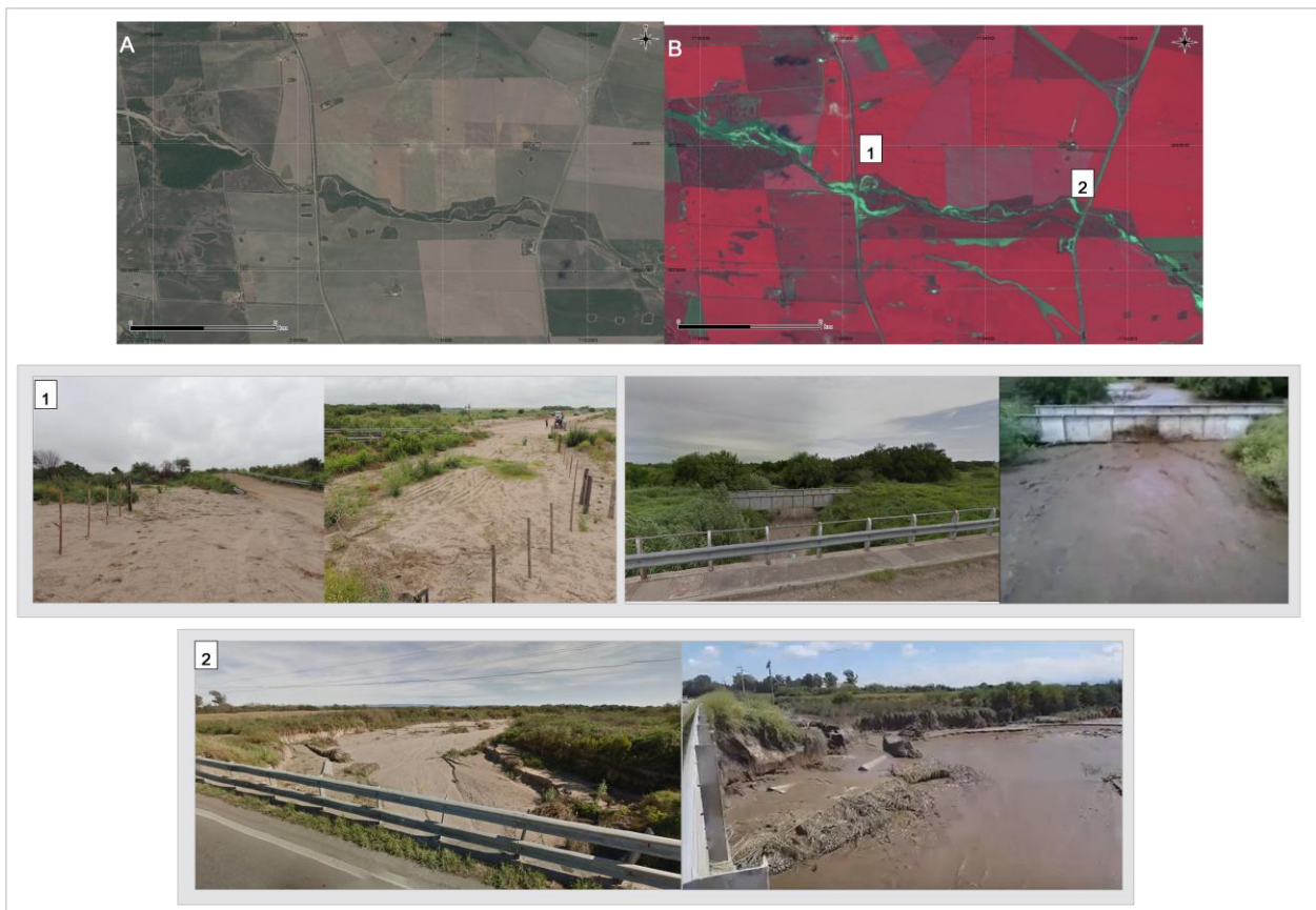
Figura 8: A) imagen año 2010. B) Spot 2015. 1- Procesos erosivos y desbordes en Puente ferroviario 2-Ensanchamiento de cauce en puente carretero RN9.
