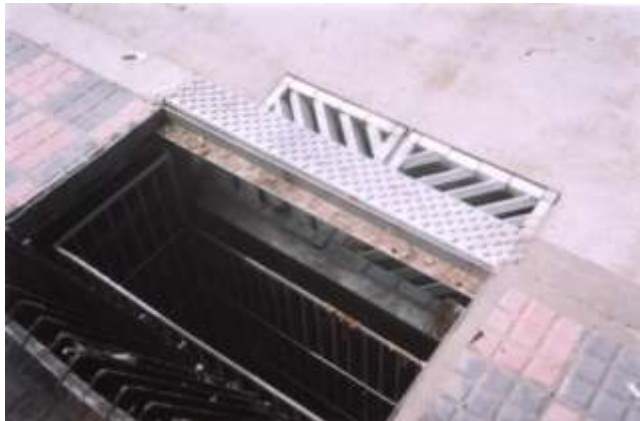
Instalación dispositivo y bocas de tormenta en Adrogué
