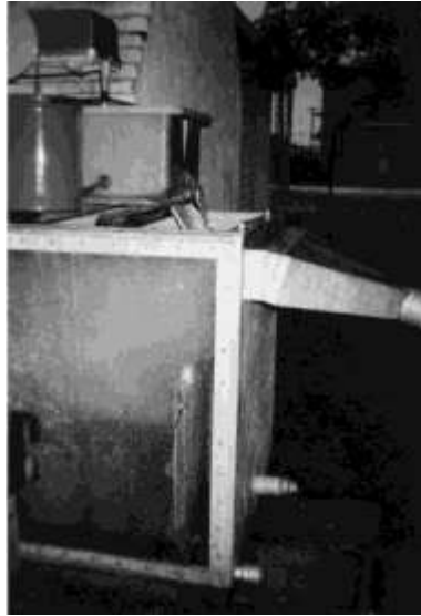
Figura 7: Instalación del dispositivo regulador domiciliario en el edificio del CRL.
