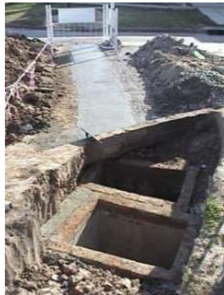
Instalación dispositivo regulador de crecidas en bocas de tormenta
