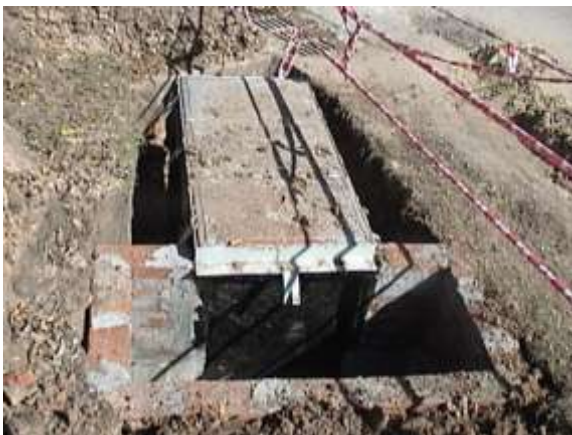
Instalación dispositivo regulador de crecidas en bocas de tormenta
