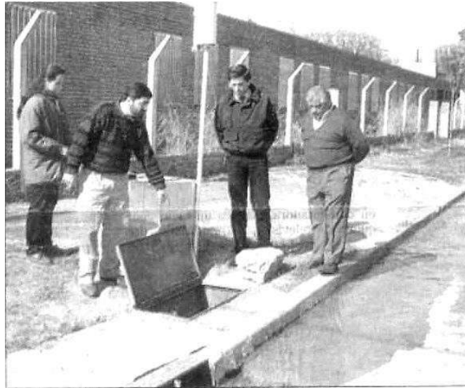
Figura 4: Instalación experimental del dispositivo regulador en bocas de tormenta. Durante el periodo de operación se registraron 11 tormentas de las cuales se seleccionaron dos que por su intensidad y producción de caudal pico, muestran la funcionalidad del dispositivo.
