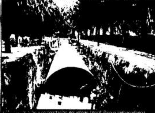
Se realiza y compacta el relleno lateral Parque Independencia
