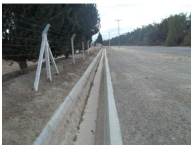
Figura N°5. Estado de mantenimiento adecuado
