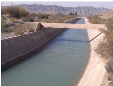
Figura N°2: Buen estado. Canal de Fuga o Descargador de Agua y Energía (Ullúm)
