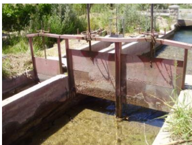
Figura N°8. Compuerta en buen estado. N°7227 Canal Falda en Zonda
