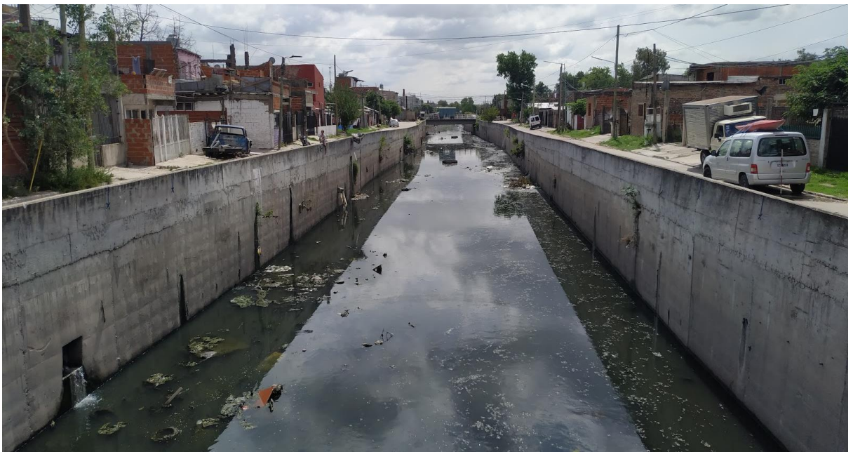
Figura 3.7. Control por tramo del canal en la Estación de Monitoreo 16 de ACUMAR (foto tomada el 04/03/2021).
