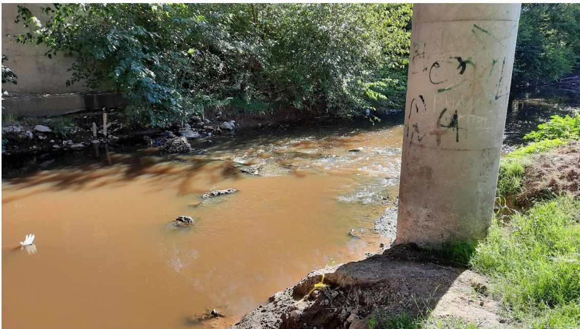
Figura A.1. Sección de control generada por estructuras en el fondo aguas abajo de la EM01.
