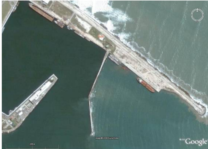
Figura 4.2: Escollera de protección de la dársena de submarinos
