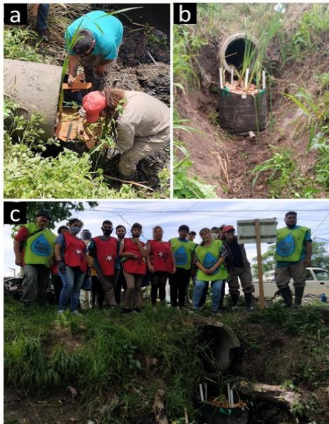
Figura 1.- a) Armado del biofiltro a la salida de desagüe doméstico-pluvial. b) Biofiltro finalizado. c) Trabajadores de la organización social que participaron de la construcción de los biofiltros.
