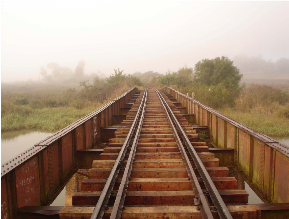
Figura 3.4: Puente ferroviario sobre el arroyo Zaimán
