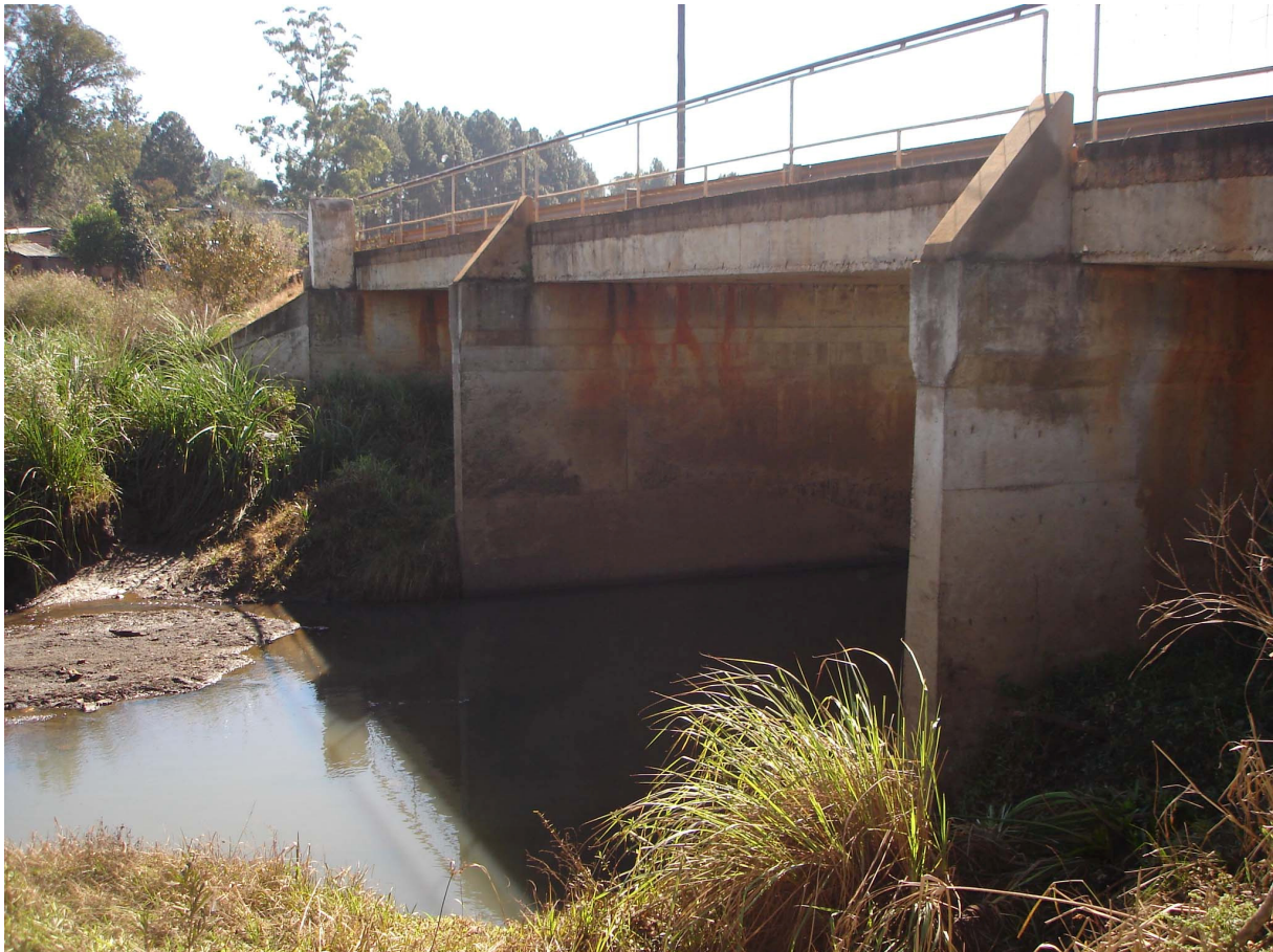
Figura 3.9: Puente de hormigón sobre el Zaimán en la zona "El Porvenir" aguas abajo
