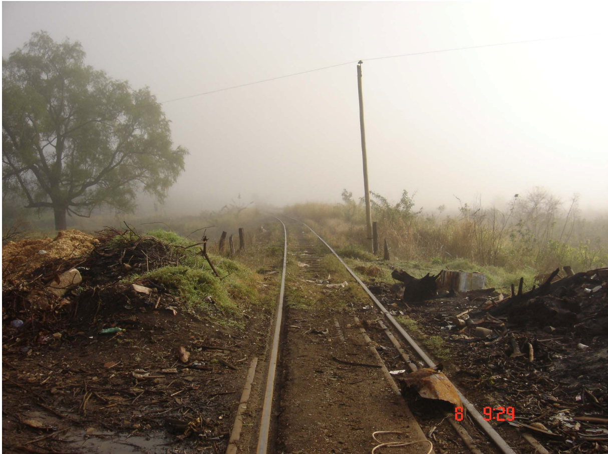
Figura 3.3: Cruce de la vía con el camino de acceso
