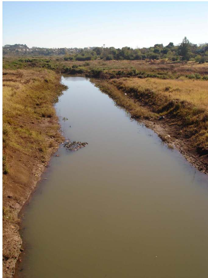
Figura 3.8: Zaimán en puente sobre Av. Cabo de Hornos aguas abajo
