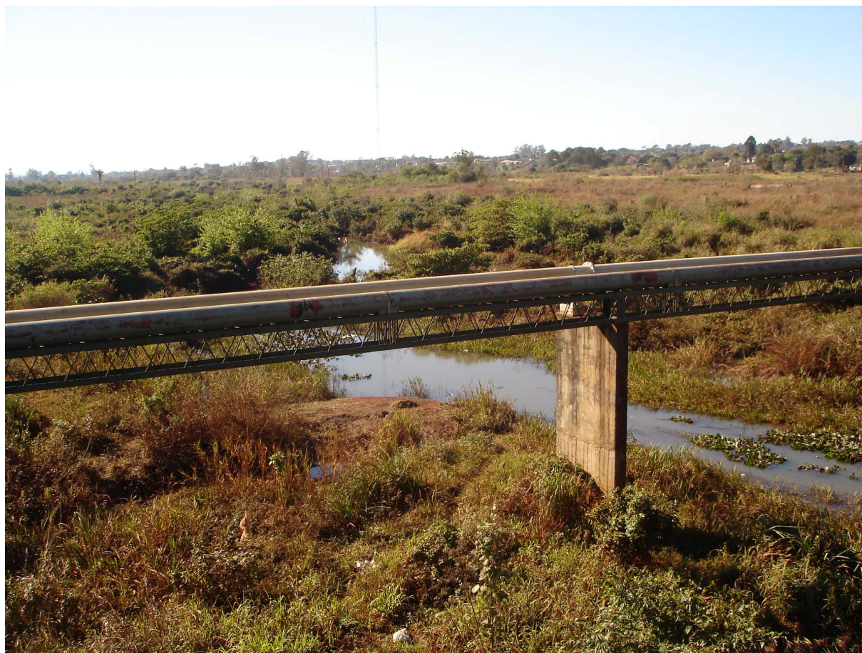
Figura 3.7: Zaimán en puente sobre RN 12 aguas abajo
