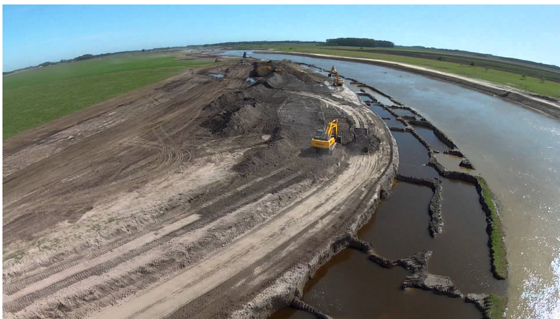
a) Dragado del río Salado a la altura del partido de General Belgrano. (Fuente: construir.com.ar)
