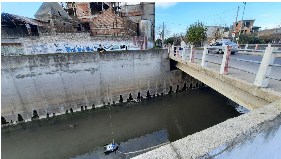
Figura A.81. Realización del aforo en Sitio I, sobre el Aº Del Rey.
