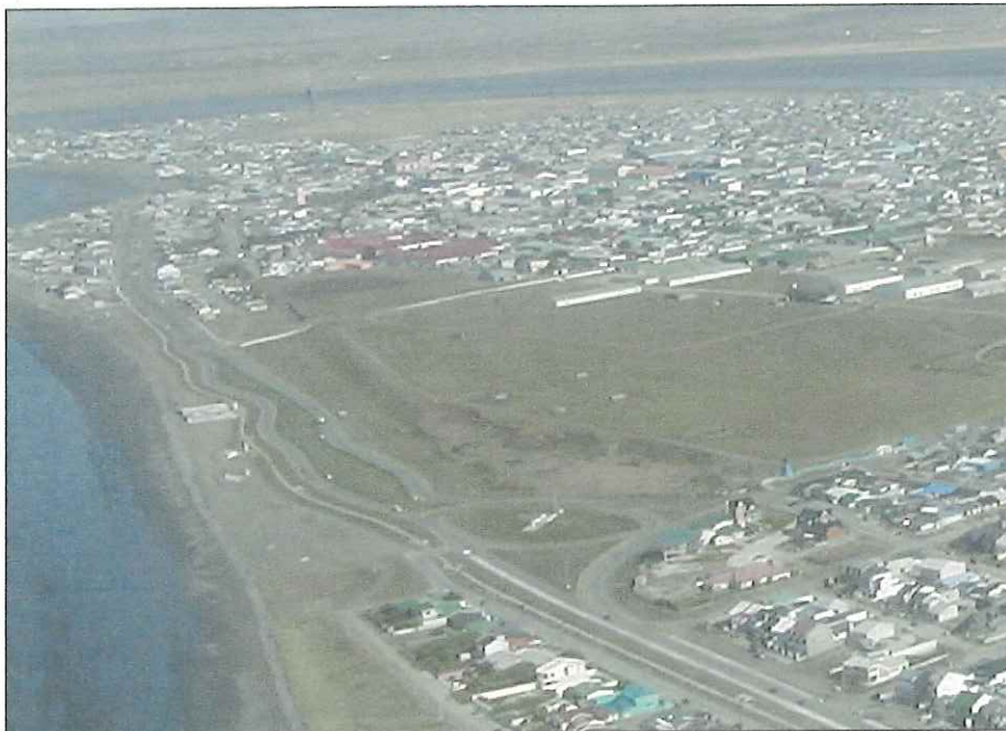
FOTOGRAFIA 3 . Vista aérea de la costa marítima en el tramo de la obra proyectada.
