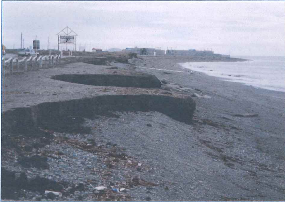
FIGURA 4 - Erosión costera por acción del oleaje
