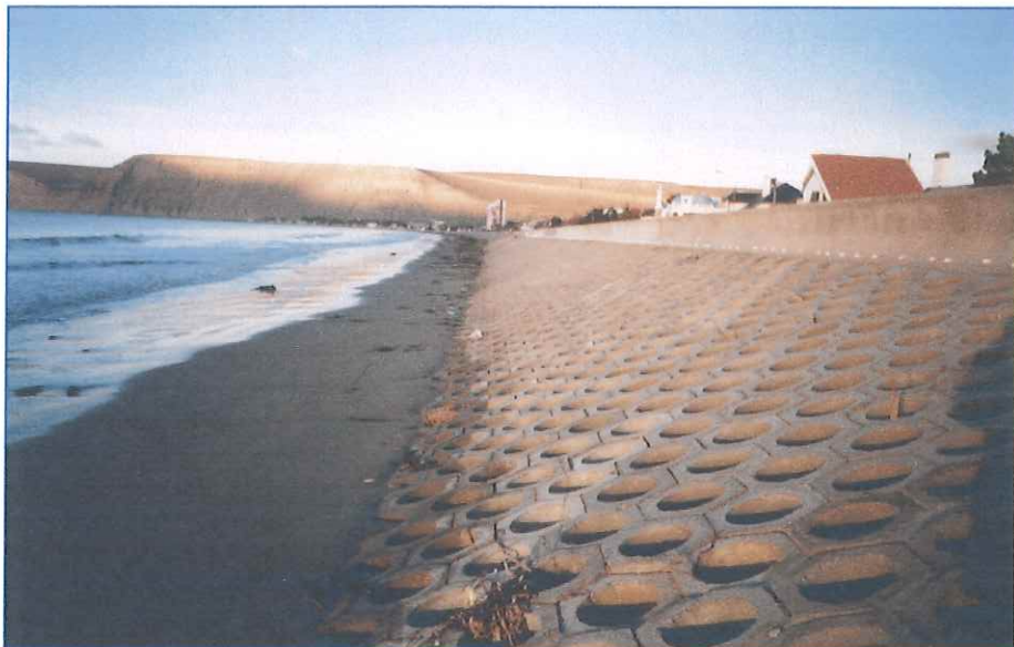
FOTOGRAFIA 5 - Obra de defensa costera en la Provincia de Chubut
