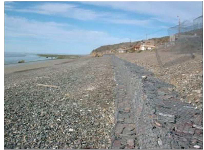
Figura 9.3: Protección longitudinal compuesta por gaviones en Playa Cangrejales realizada por la DGIP
