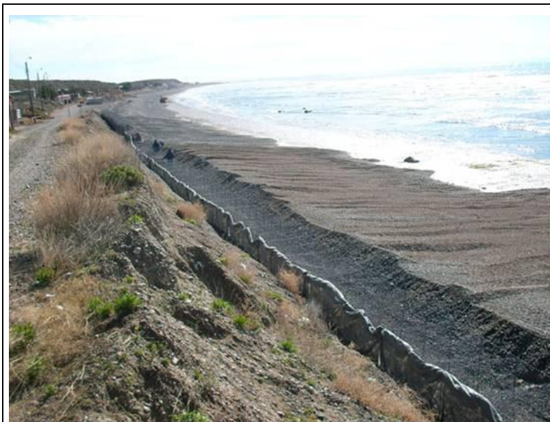
Figura 4.8: Construcción de gaviones en Playa Cangrejales
