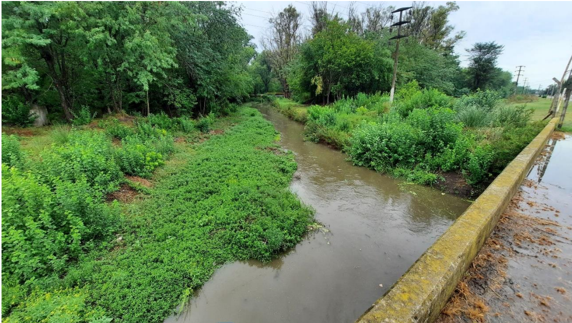
Figura A.2. Vista del Aº Aguirre desde el puente vial del Camino Real Presbítero Juan G. González y Aragón hacia aguas abajo.
