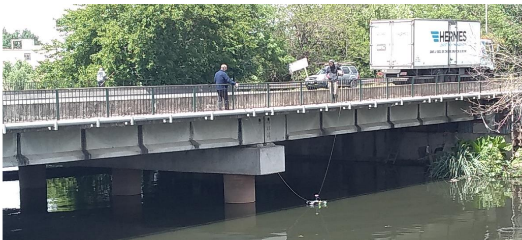
Figura A.53. Aforo con el ADCP mediante sogas desde el puente de la Av. 27 de Febrero en la EM17
