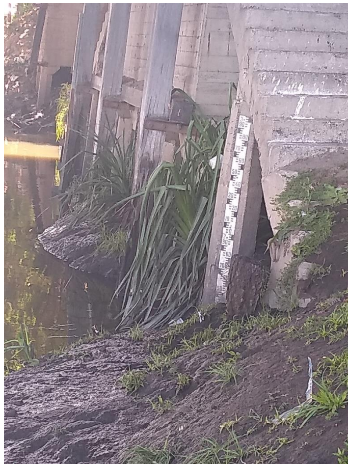
Figura A.62. Regla hidrométrica de la EM24. Se observa que el nivel del agua es inferior a la misma, no pudiéndose registrar una lectura.
