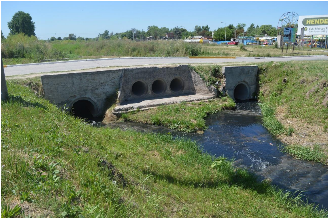
b) Alcantarillas a diferentes niveles en la EM50.
