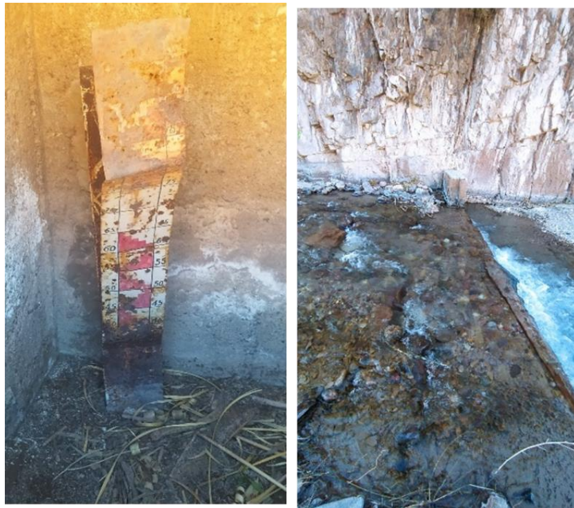
Figura 10. Escala y salto hidráulico en desuso
