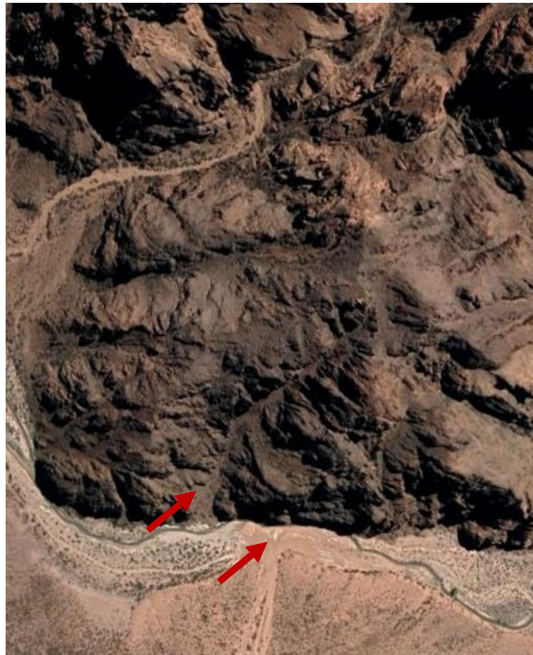
Figura 15. Ubicación de aportes laterales de agua no controlados
