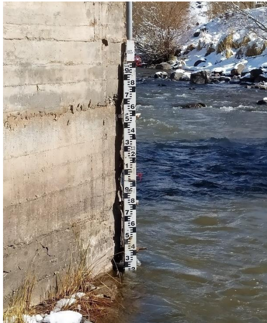
Figura 16. Ejemplo escala hidrométrica instalada sobre el estribo de un puente
