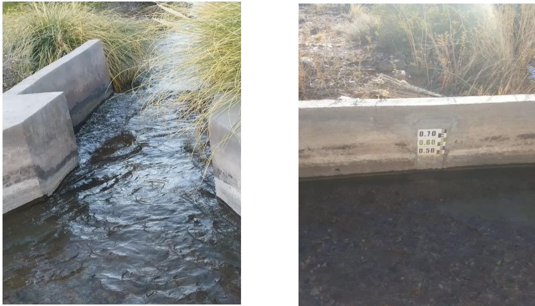
Figura 3. Aforador y escala
