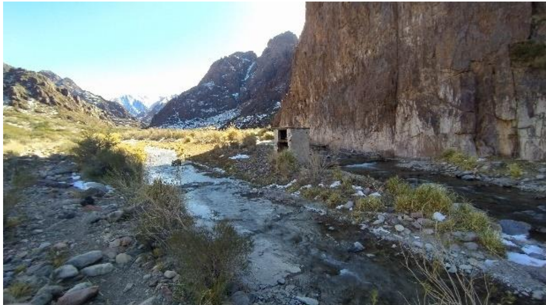
Figura 7. Bifurcación del cauce, casilla y aforador abandonados vista hacia aguas arriba
