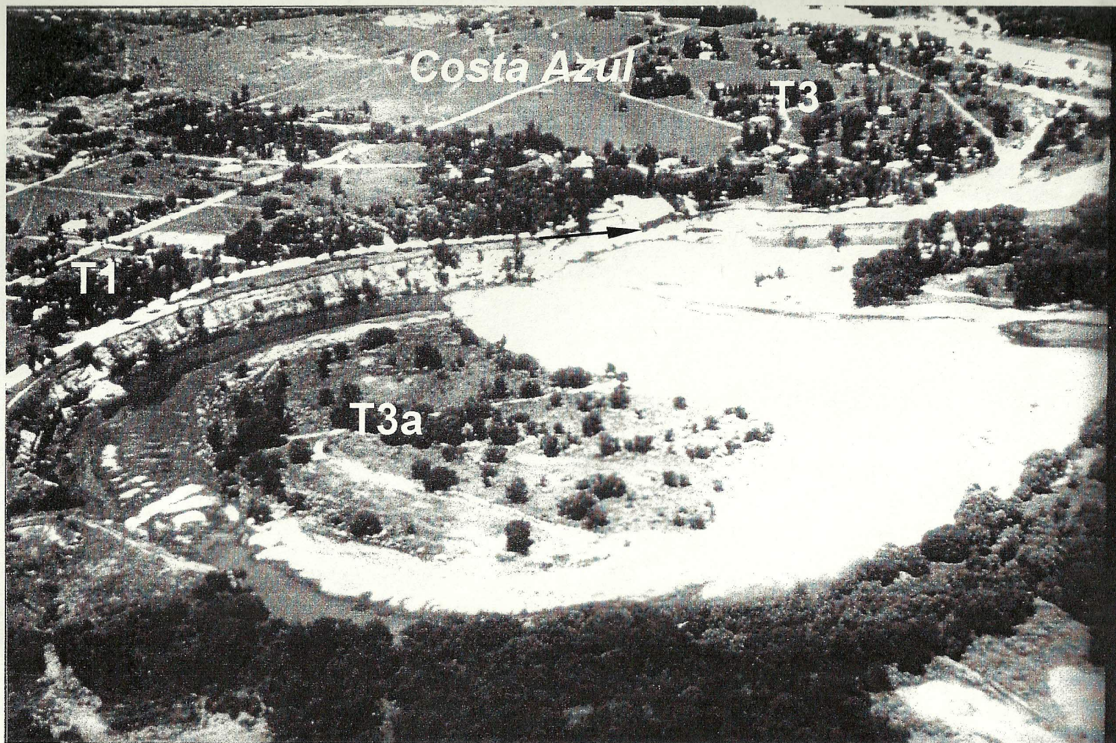
COSTA AZUL: estrangulamiento de meandro (1993). Situación de amenaza severa ante la ocurrencia de crecientes extremas por el probable ingreso frontal de los picos de crecidas sobre el nivel inferior de terraza T3
