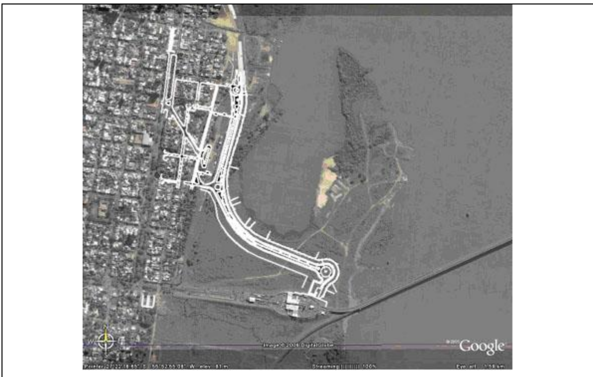
Figura 2. Detalle de la ubicación del tramo de obra de defensa
