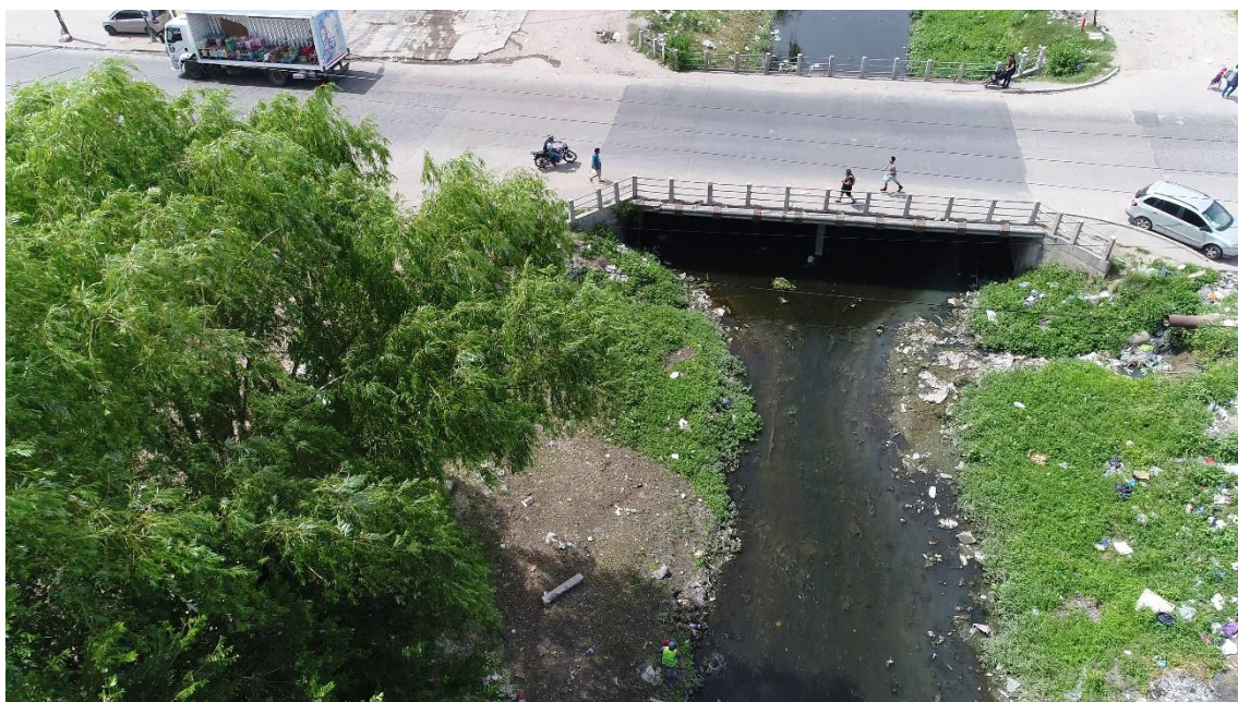
Figura A.38. Vista aérea (tomada con dron) de la sección de aforo de la EM14 desde aguas abajo hacia aguas arriba.
