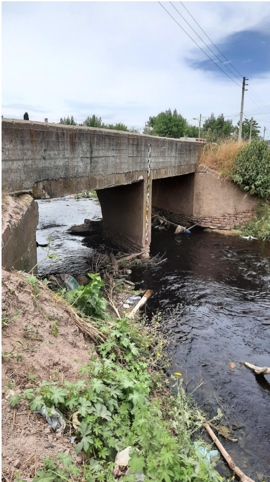
Figura A.10. Tramo 2 y 3 de la regla hidrométrica. Ambos presentaban muchos sectores ilegibles. Se observa también la presencia de residuos sólidos y ramas en un tramo del puente.
