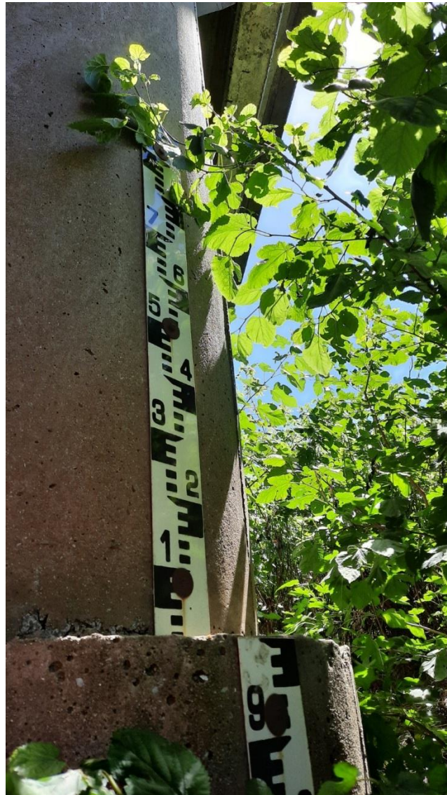
Figura A.8. Tramo 3 y 4 de la regla hidrométrica ubicados en la pila del puente sobre margen derecha. Ambos tramos se encuentran en buen estado.
