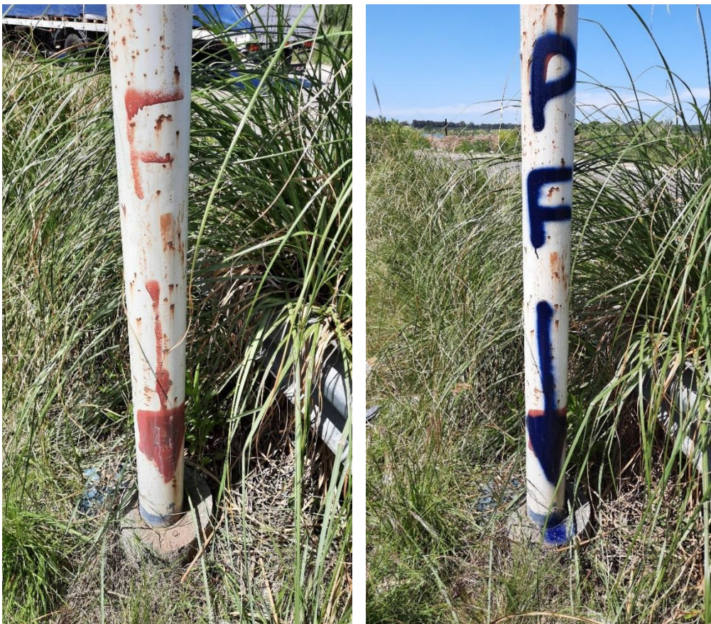
Figura A.15. Señalización del Punto Fijo de la EM06
