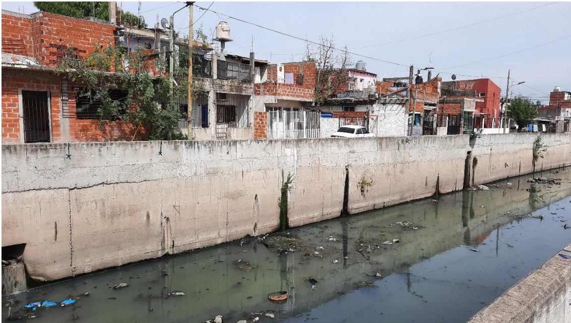
Figura A.42 . Señalización y relevamiento de la cota IGN de distintos puntos de referencia para implementar la técnica de aforo LSPIV en la EM16.
