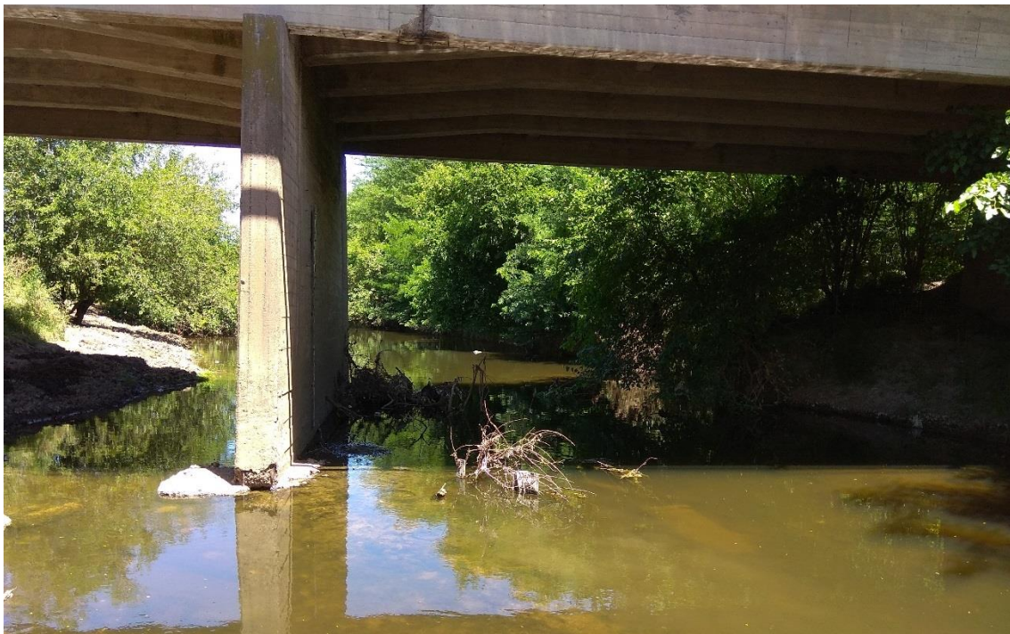
Figura A.2. Vista de la sección de aforo de la EM01 desde aguas abajo hacia aguas arriba. Se observa abundante vegetación sobre margen derecha.
