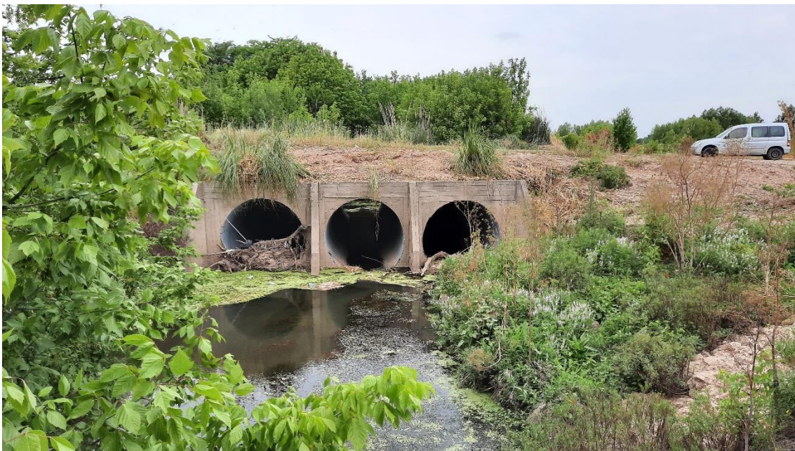
Figura A.61. Sección de aforo de la EM47 vista desde aguas arriba hacia aguas abajo. Se puede observar la estructura de alcantarillas donde se marcó el nuevo Punto Fijo.
