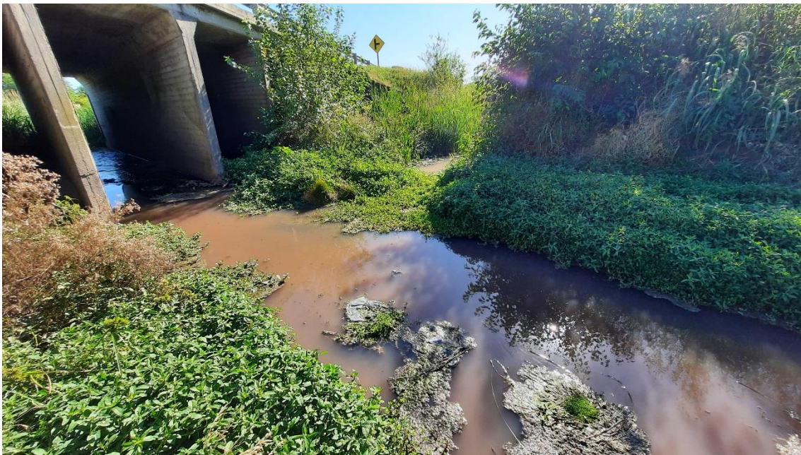
Figura A.53. Sección de aforo de la EM39. Vista tomada desde la margen izquierda.
