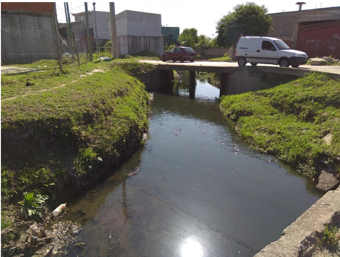
Figura A.78. Sección de aforo de la EM77 vista desde aguas arriba hacia aguas abajo.
