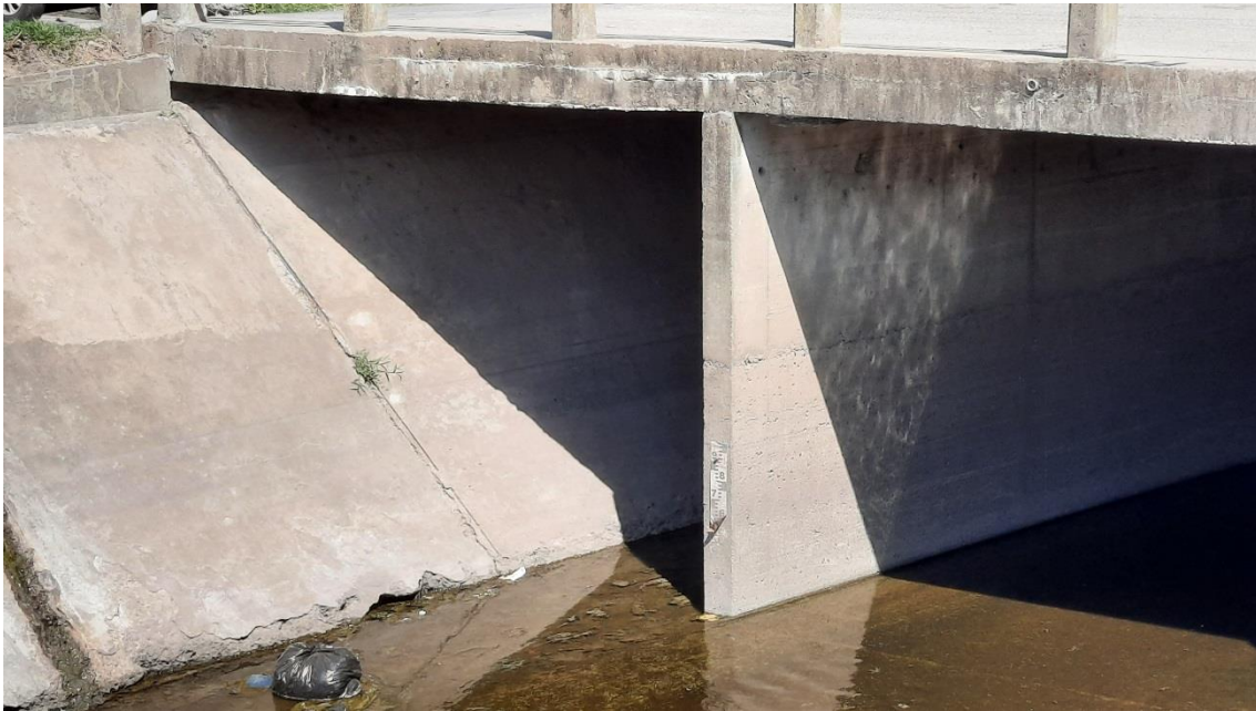
Figura A.75. Tramo incompleto de la regla hidrométrica de la EM76
