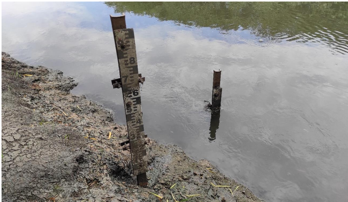
Figura A.35. Tramos 1 y 2 de la regla hidrométrica. Ambos en correcto estado (solo requieren una limpieza para hacer legibles las marcas).
