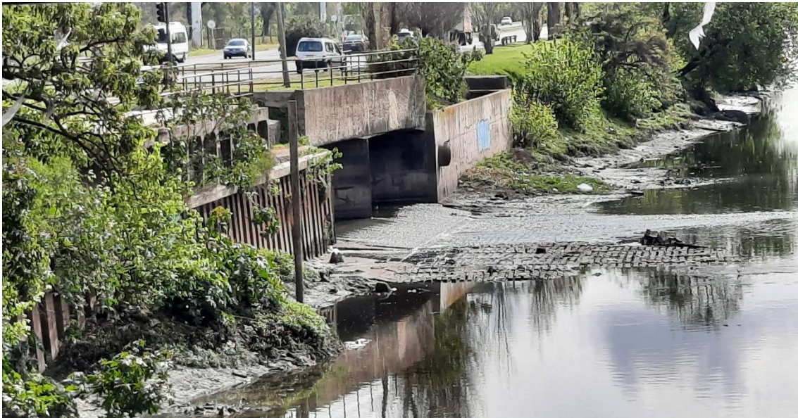
Figura A.80. Vista de la descarga del Aliviador del arroyo Cildañez tomada desde el Puente La Noria.
