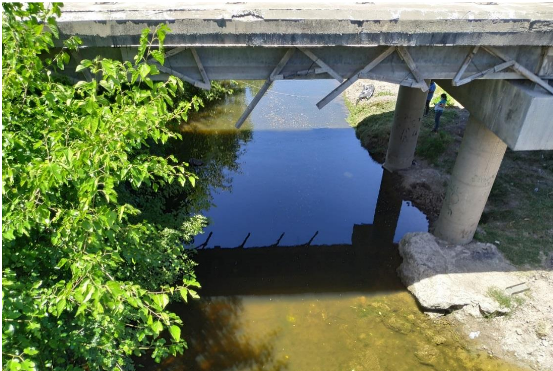
Figura A.1. Vista de la sección de aforo de la EM01 desde aguas arriba hacia aguas abajo. Se observa abundante vegetación sobre margen derecha.
