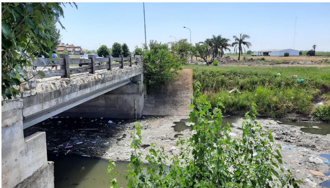
Figura A.24. Vista de la sección de aforo de la EM11 desde margen derecha. Se puede observar la regla hidrométrica en el estribo del puente sobre margen izquierda.
