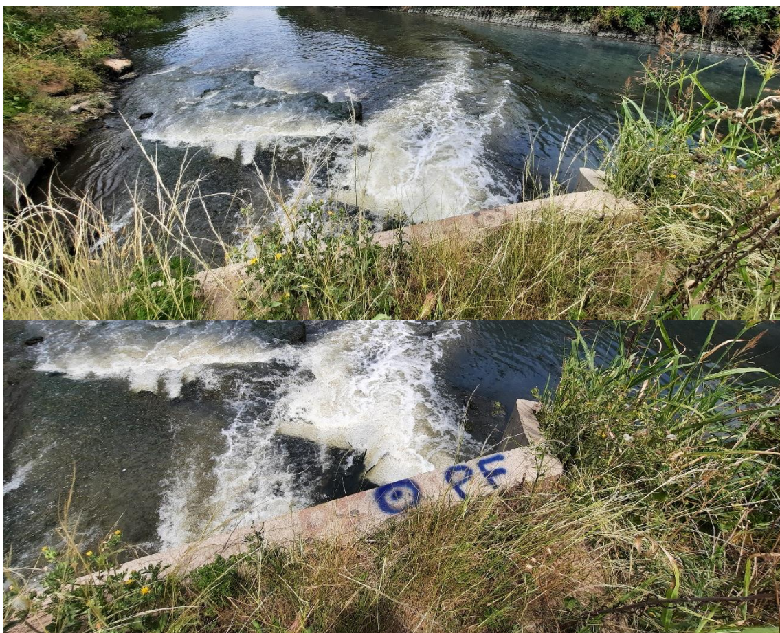
Figura A.36. Remarcación del Punto Fijo de la EM13.
