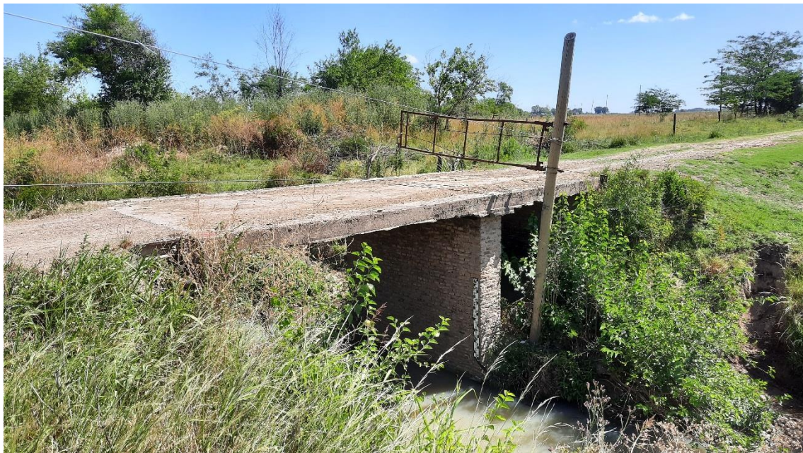
Figura A.57. Tranquera cortando el paso sobre el puente de la EM41. En el estribo de margen izquierda se observa la regla hidrométrica.
