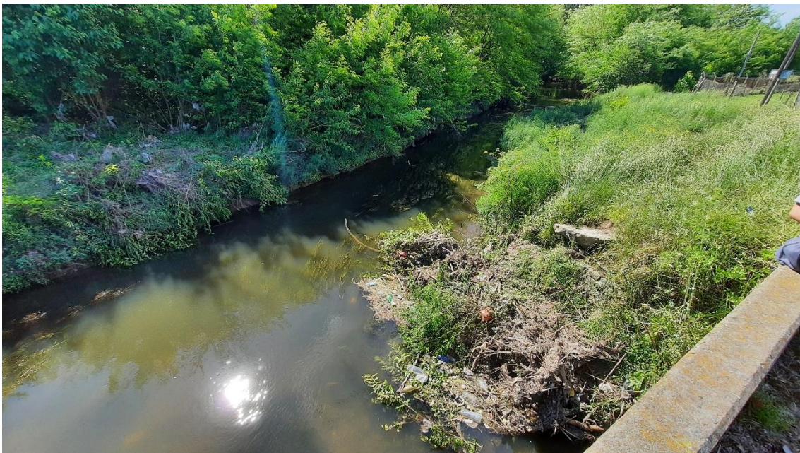
Figura A.22. Sección del arroyo Aguirre aguas abajo del puente del Camino Real.
