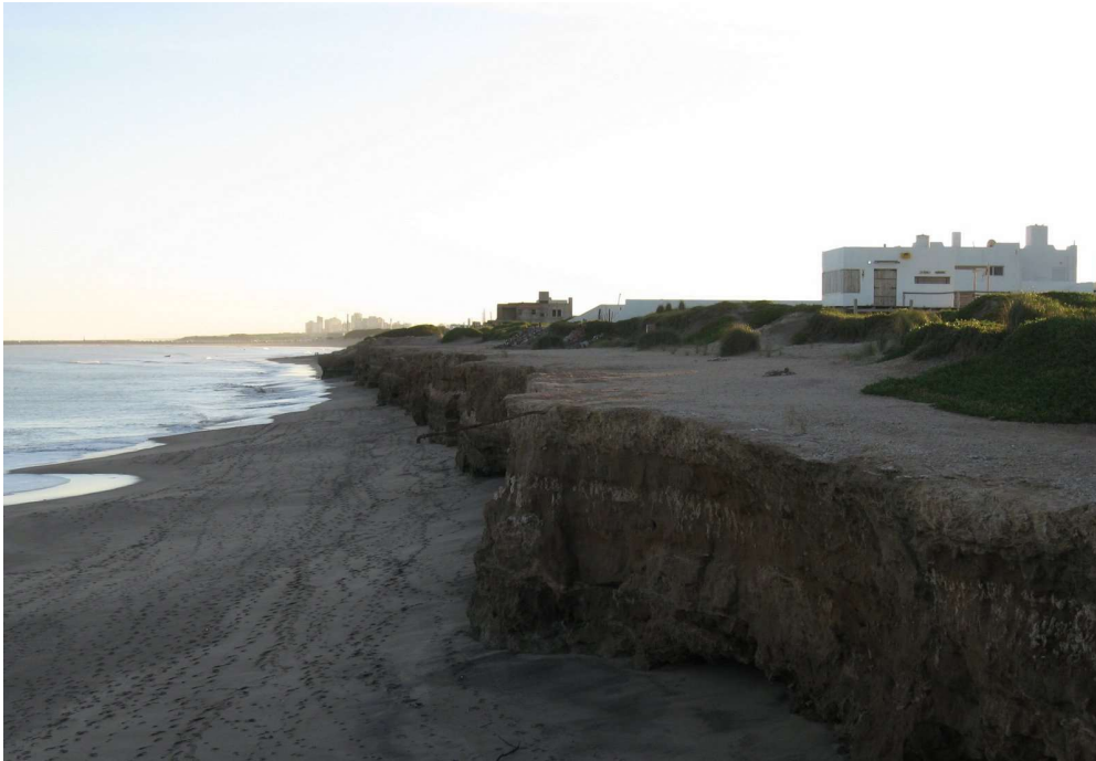
Figura 3.3. Urbanizaciones próximas a acantilados en retroceso – Bahía de los Vientos.
