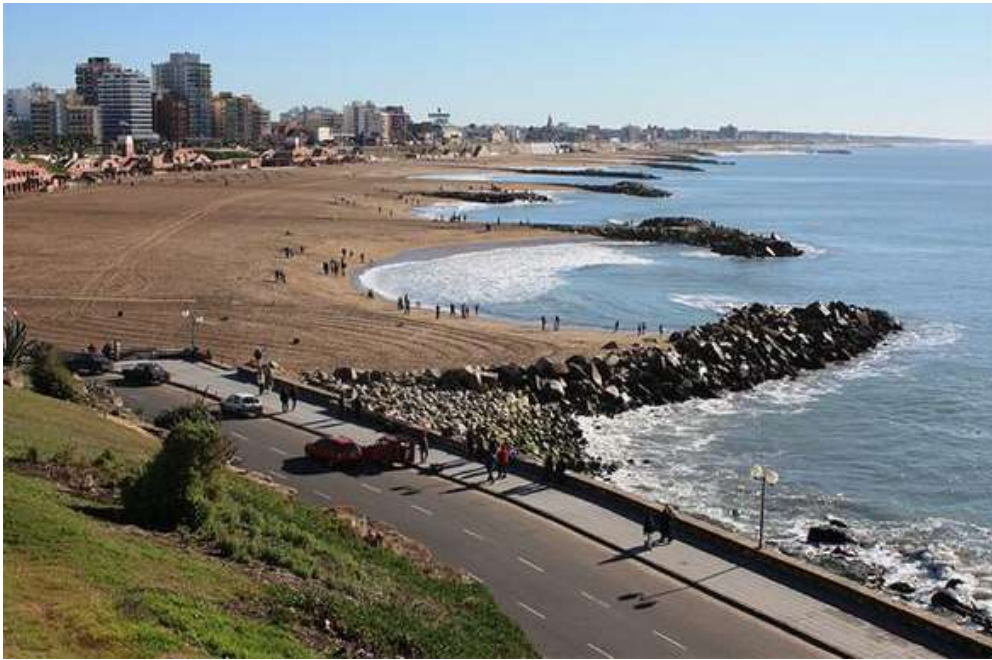
Figura 3.6. Escolleras como mecanismo de retención de sedimentos – La Perla, Mar del Plata.
