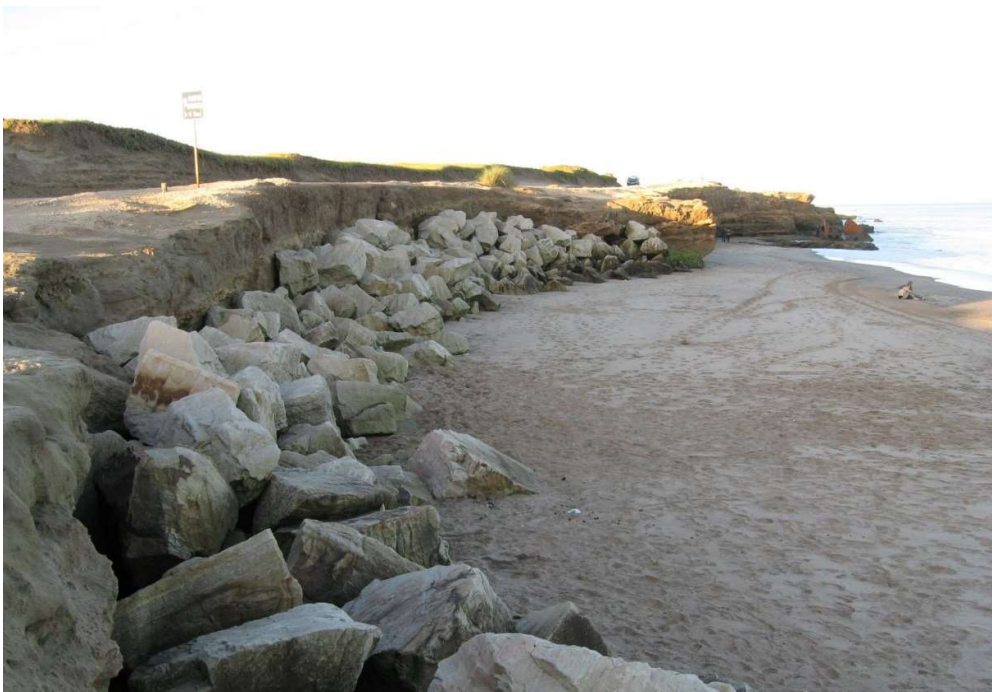
Figura 3.4. Rip-Rap como protección de acceso vehicular – Bahía de los Vientos.
