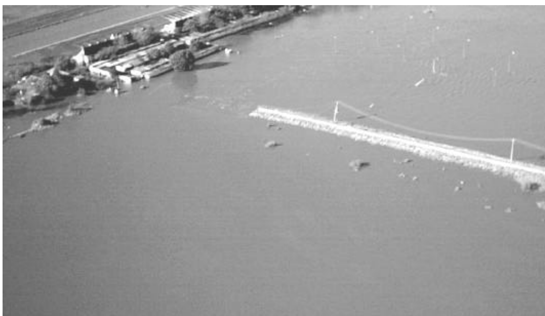
Figura 8.- Ingreso del agua por el extremo norte de la defensa que no fue superada
