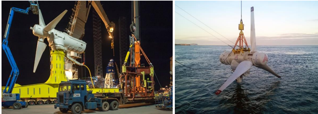
Figura 2.23. Instalación de turbina AR1500 en el parque MeyGen.
