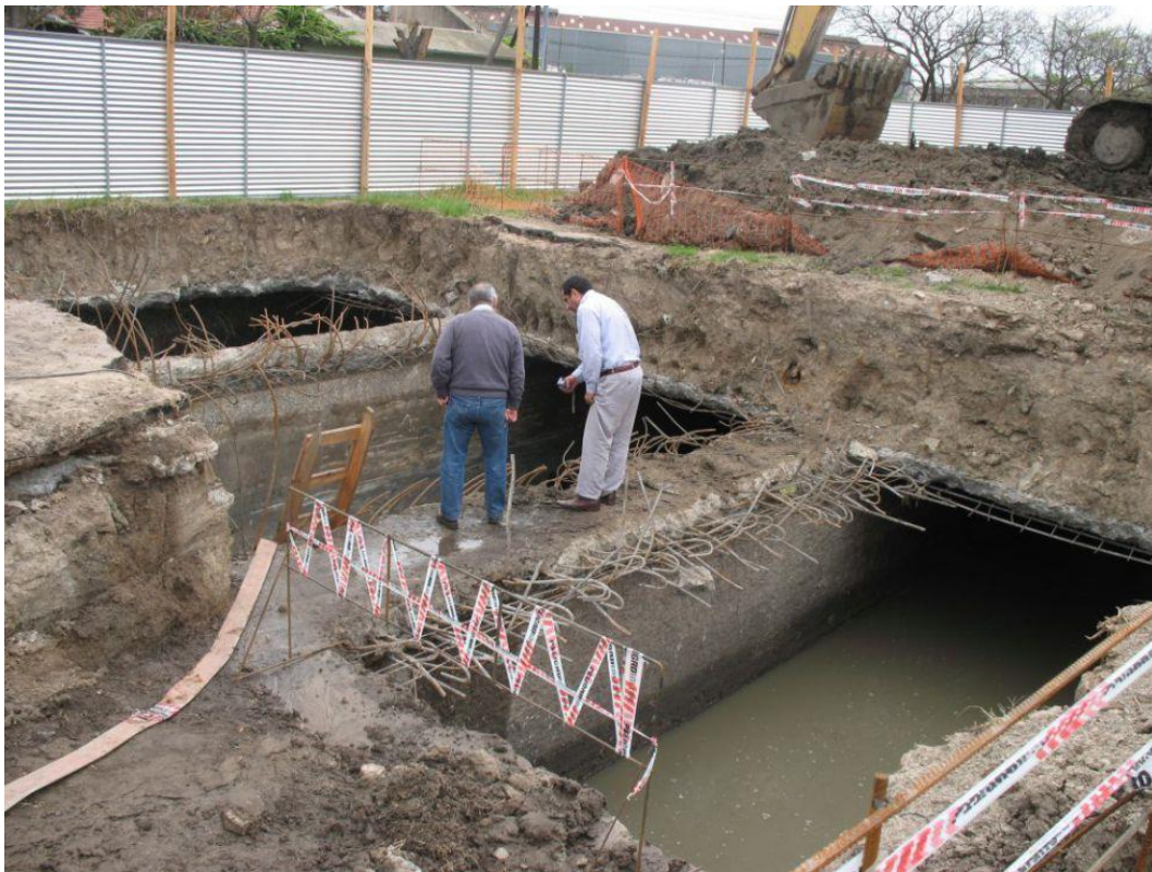
Figura AI.3. Entubamiento Arroyo Galindez – Tramo 4 (Intersección de las calles Teniente Coronel Brueras y Deheza – Lanús Este – Lanús).
