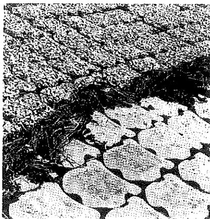
Fotografía N° 1: Protección mediante bloques sueltos o individuales.
