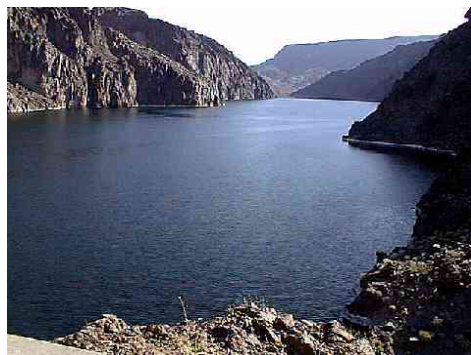
Figura 5.11 – Topografía del lago Mead.
