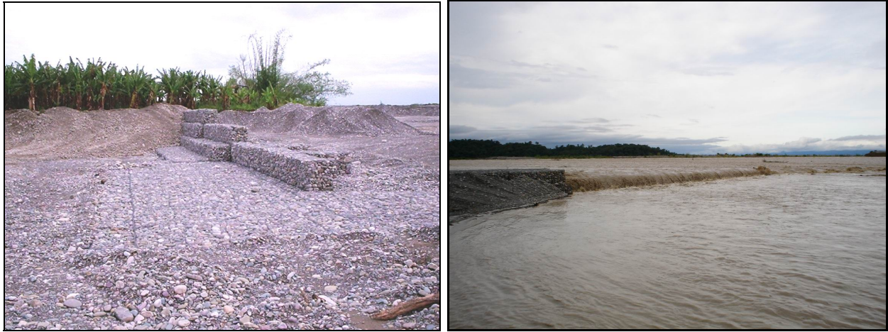
Figura 4.- Vista de un espigón en condiciones secas y durante la pasada de la onda de crecida
