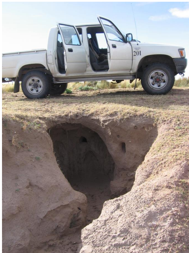
Fig. 28. Erosión tubificada – piping. Nacientes A° Nuevo
