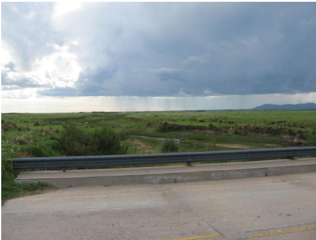
Fig.39. A° La Punilla en el cruce de la ruta Pcial. N° 1. Estabilización del cauce por presencia de vegetación en márgenes y fondo.
