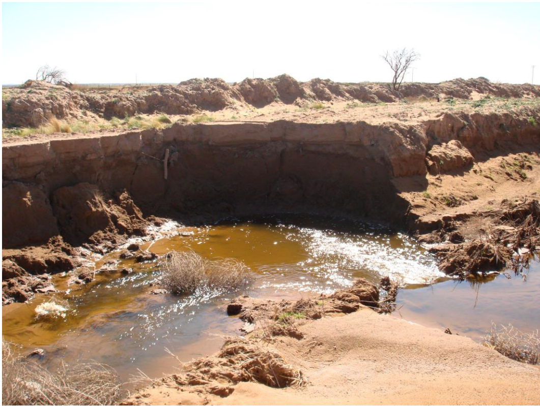
Fig. 55. Erosión de márgenes – desplome. Diseño meandriforme incipiente. Canal de Trasvaso.
