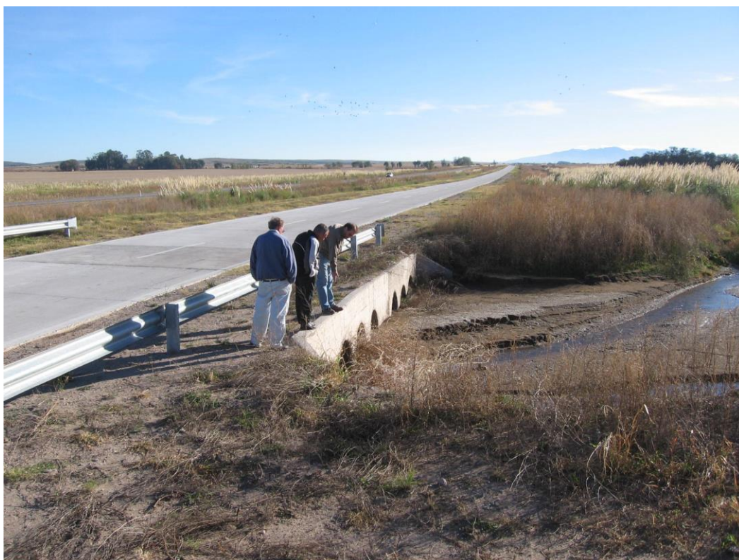
Fig. 74 Obra de alcantarillado sobre ruta Nac. Nº 148
