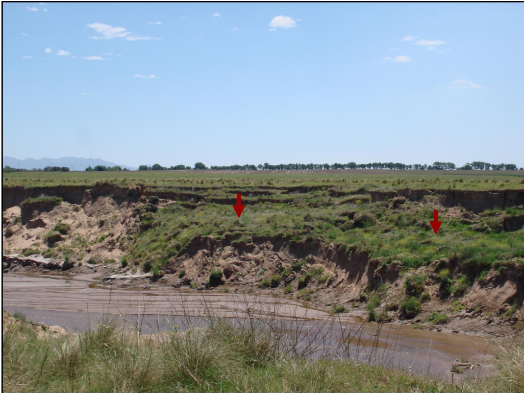
Fig.31. Desplome por descalce de base por erosión fluvial con probable efecto de disolución. Sistema A° Nuevo. Nivel freático aportante (curso efluente).Foto N° 8. Curso efluente con aporte de freática. Sistema A° Nuevo.
