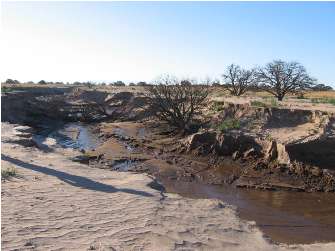
Fig. 61. Sistema A° Nuevo. Desplome reciente
