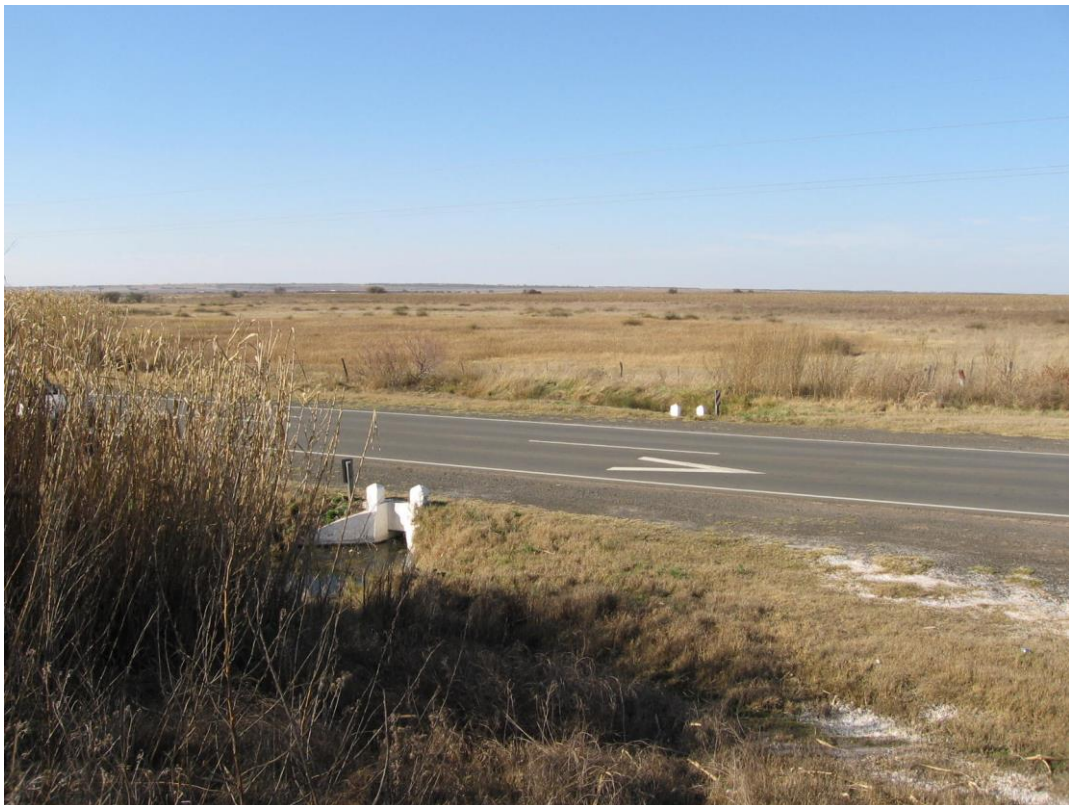
F. 54. Alcantarilla sobre ruta Nac. N° 8. Desagüe coincidente con los derrames con mayor grado de definición. Al fondo vegetación hidrófila de bañados.
