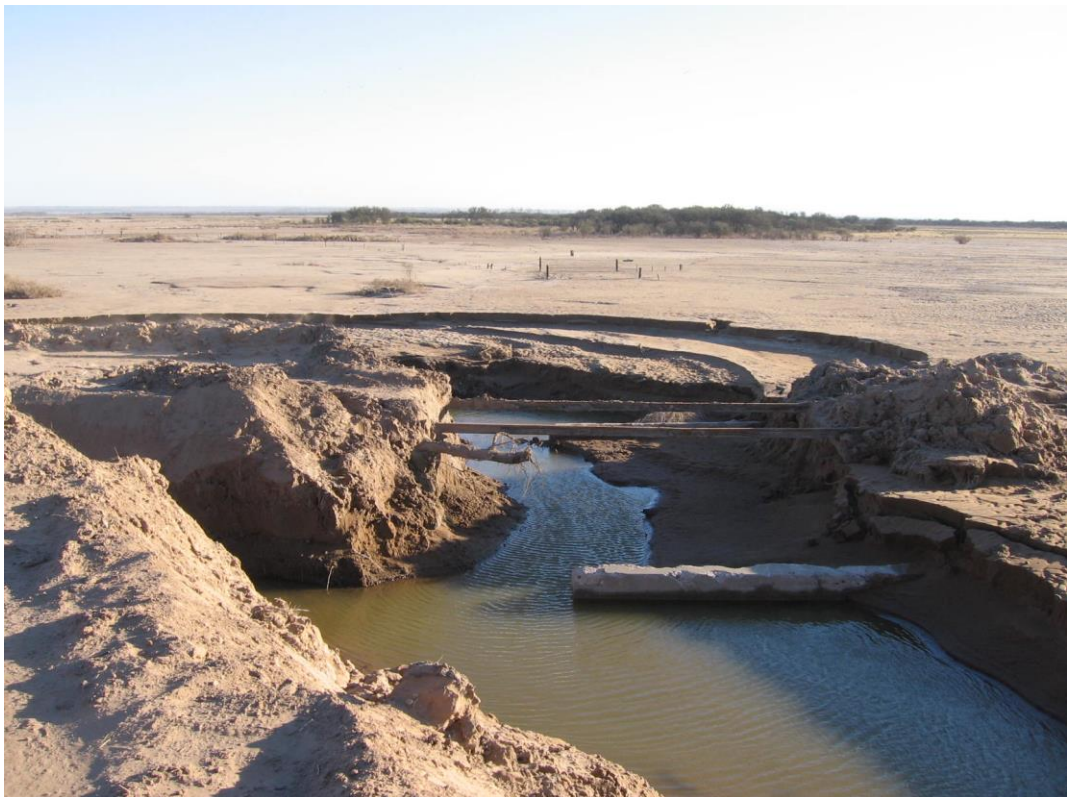
Fig. 71. Ídem a Fig. anterior. Vías del ferrocarril enterradas por aluvionamiento inmediato al norte de la ruta Nac. N° 8. Depresión La Salada .
