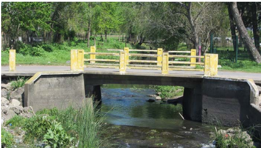
Figura 2.30. Puente Arroyo Colorado y Av. Cervantes.
