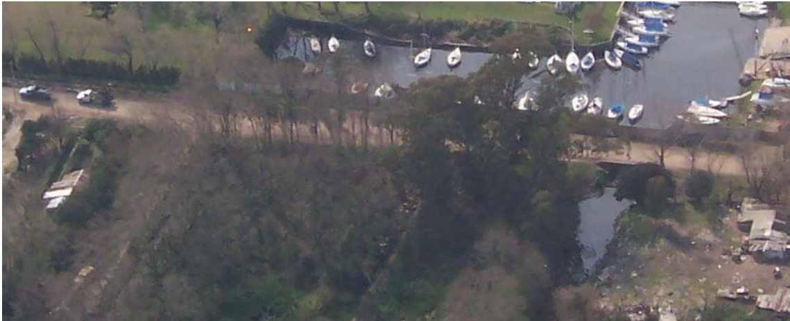
Figura 2.12. Puente Club Náutico.
