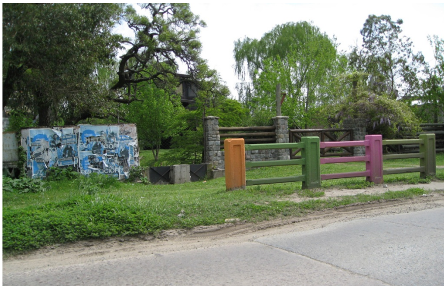
Figura 2.11. Pequeña estructura de control sobre Av. Cervantes.
