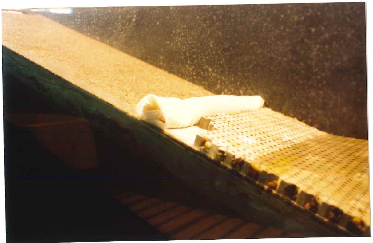
Foto 12: Armado de talud de unidades Betoncover sobre filtro.
