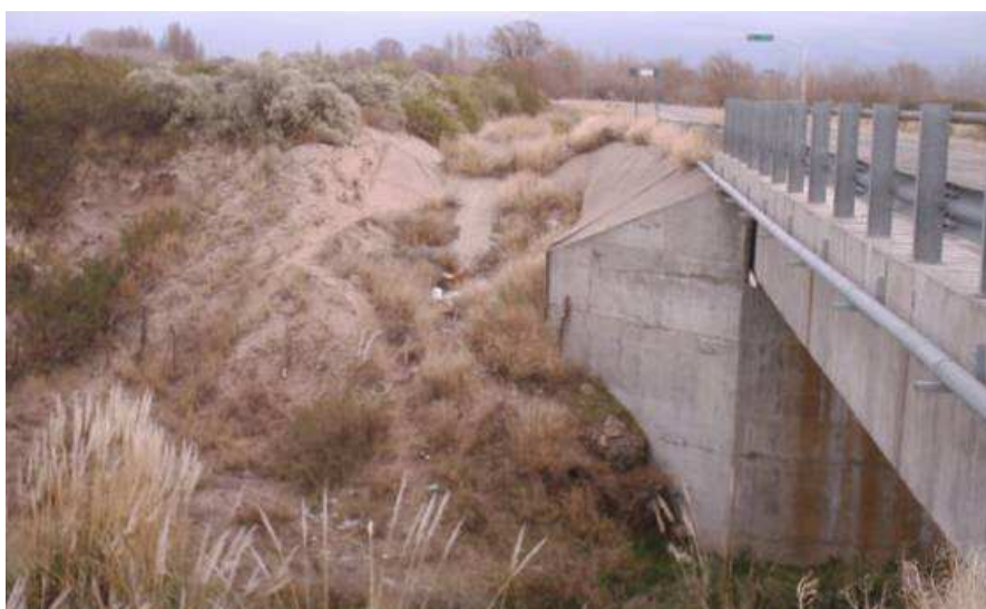
Figura 17.- Fotografía de salto sobre estribo izquierdo (situación previa)
