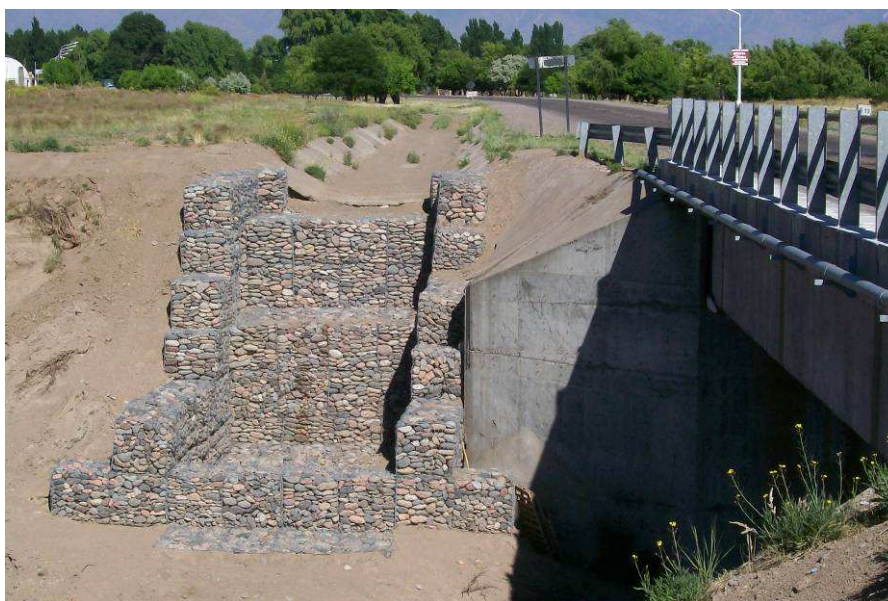
Figura 18.- Fotografía de Escalera de gaviones para control de erosión (obra en ejecución)
