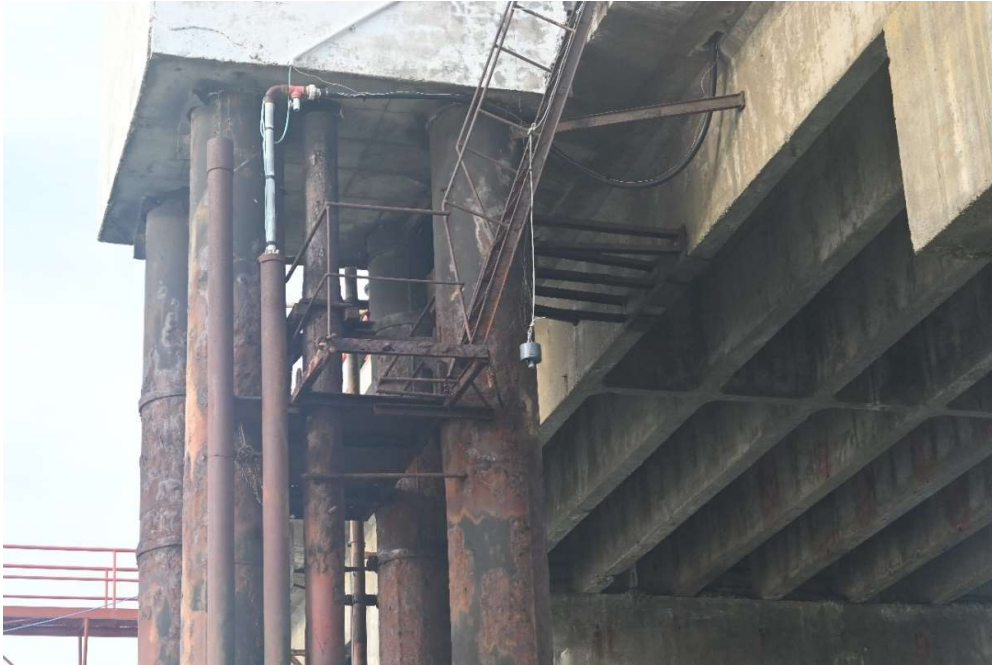
Figura A-I.9. Sensor de nivel colocado en el puerto de Punta Quilla.
