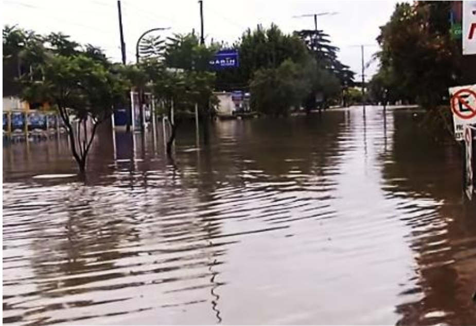
Figura 38. Imagen tomada sobre Av. Goycochea en Villa Allende, a 200 m aproximadamente del puente Maluf.
