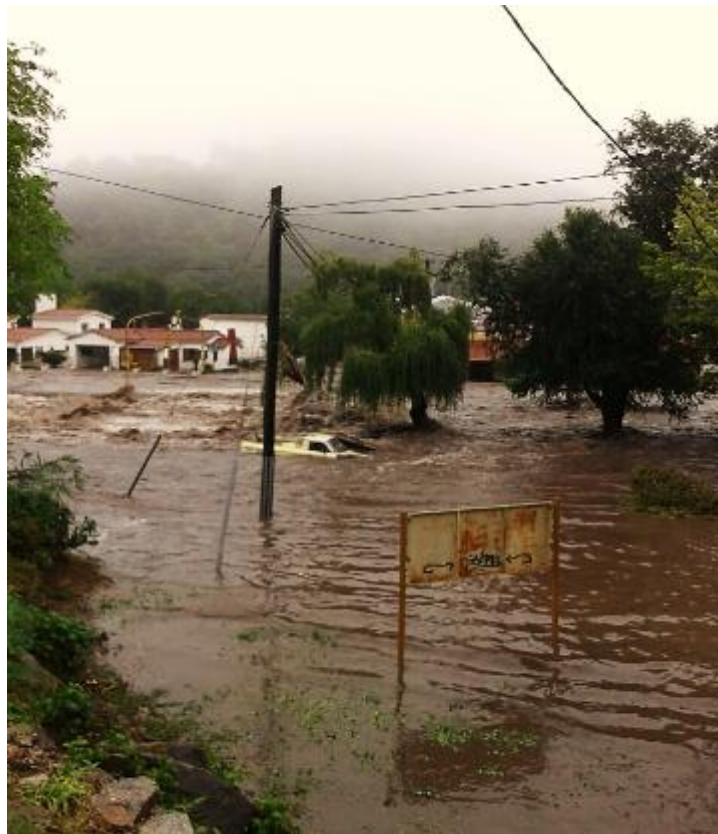
Arriba; imagen del año 2014. Intersección de Av. San Martín y calle Falucho; en Río Ceballos. Abajo; fotografía tomada durante el evento de Febrero de 2015.
