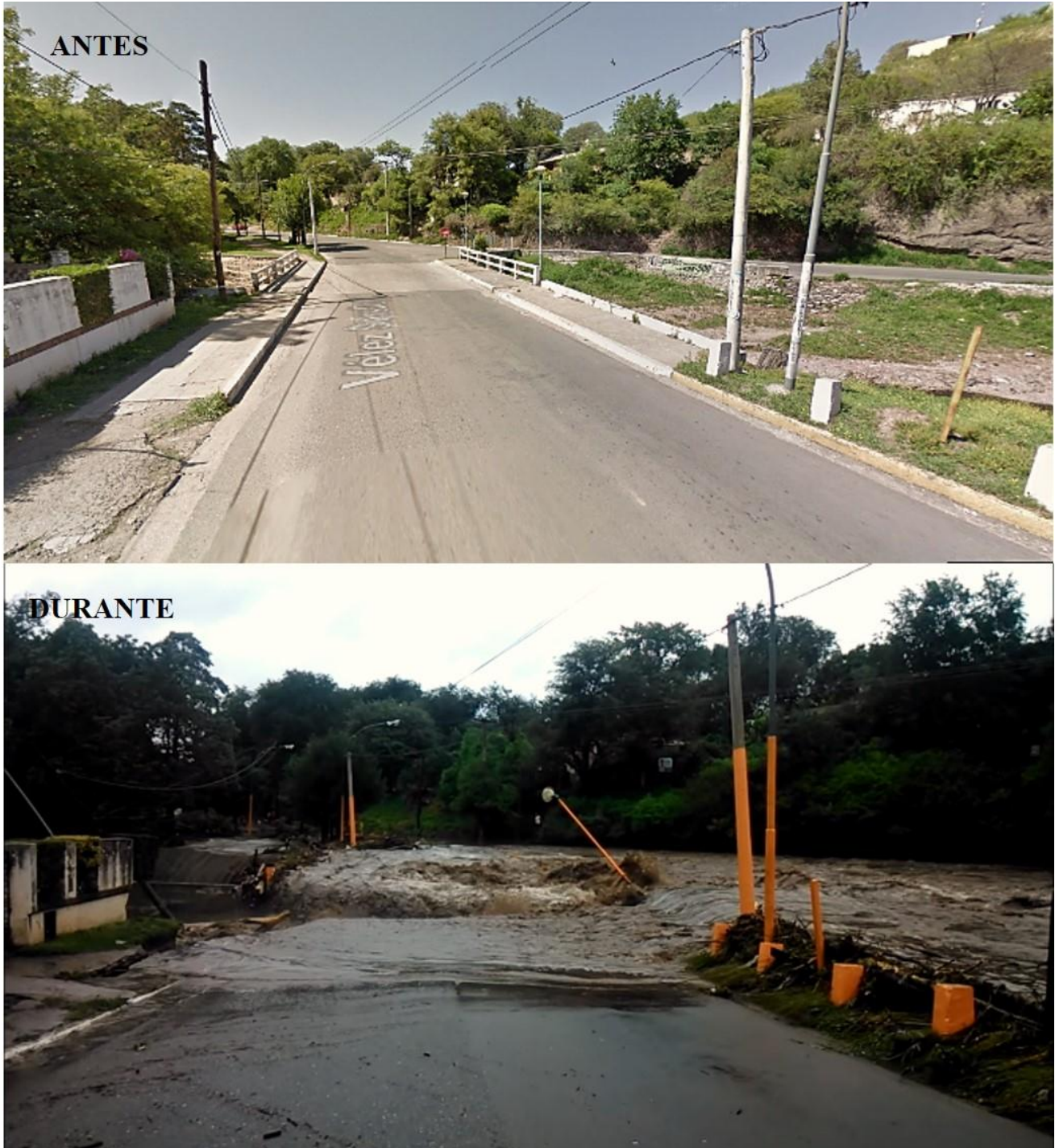
Figura 36. Arriba; imagen Street View, año 2013. Abajo; fotografía posterior al pico máximo de la crecida histórica del 15 de Febrero de 2015. Ubicación: intersección de Av. Vélez Sarsfield con Av. Latinoamérica; Saldán. Rótura completa del puente principal.
