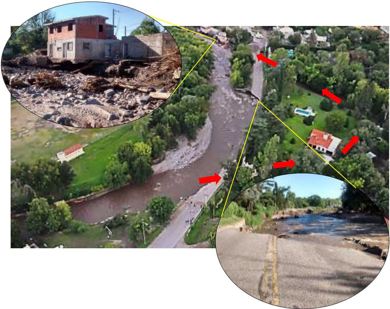
Imagen aérea de fondo: tramo de ruta intermunicipal colapsado por erosión acelerada de margen, entre las localidades de Mendiolaza y Unquillo. El cauce buscó retomar un antiguo brazo (ver carta geomorfológica) de escurrimiento (flechas rojas). Imagen arriba: rotura y colapso casi total de vivienda. Imagen abajo: fotografía tomada sobre ruta E-57 donde se observa el ensanchamiento producido.
