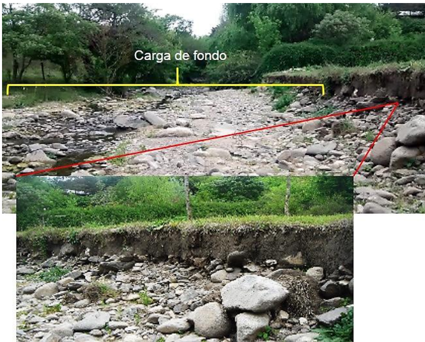
Figura 20. Carga de lecho más antigua aflorando sobre la margen izquierda del arroyo Cabana.
