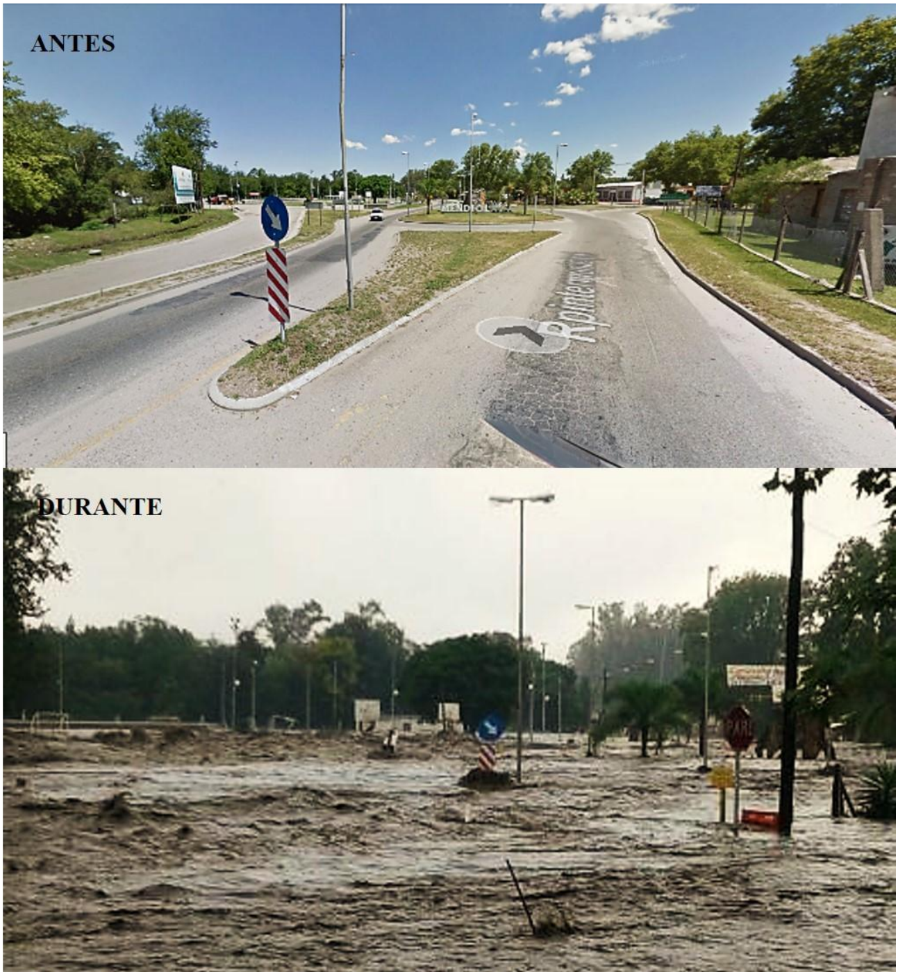
Figura 32. Arriba; imagen Street View, año 2014. Abajo; fotografía tomada durante el evento extraordinario del 15 de Febrero de 2015. Ubicación: Ruta Intermunicipal E57, a 50 m de rotonda en Mendiolaza.
