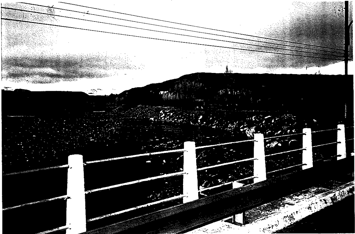
FOTO N° 4 VISTA DEL PUENTE - EROSION MARGEN DERECHA.
