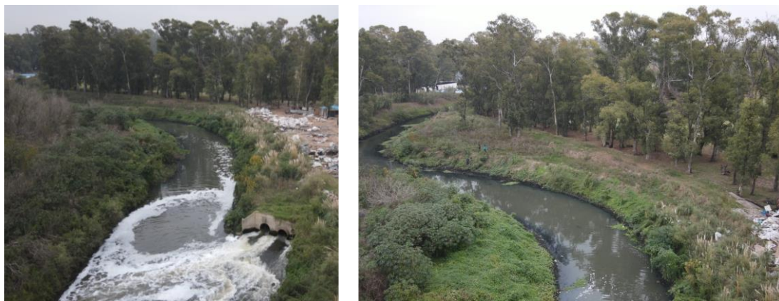
Figura A.94. Flujo inverso en la EM73 debido a la descarga de la Planta Sudoeste (izquierda) y sección de aforo (derecha).
