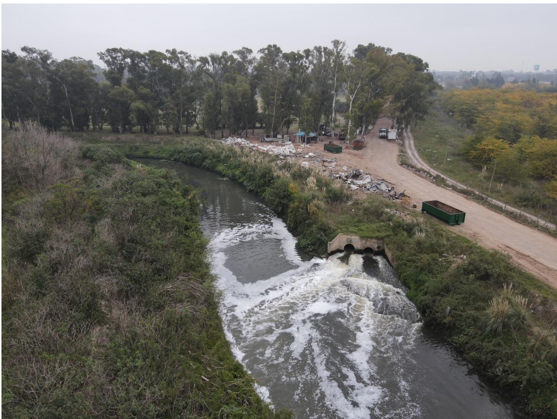
Figura A.36. Espuma generada por la descarga de la Planta Sudoeste utilizada como trazadores para el aforo con LSPIV en la EM13.
