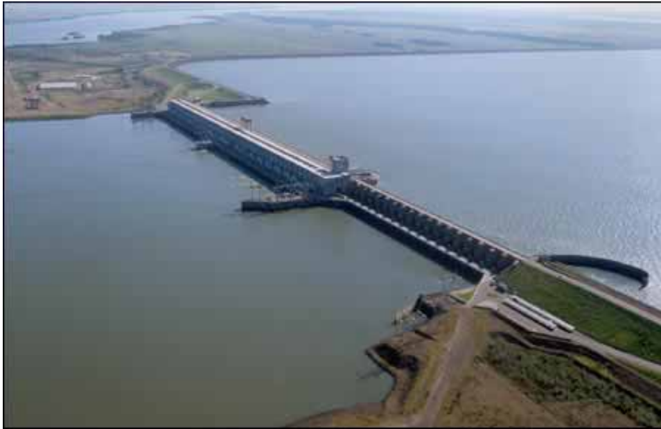
Figura 1.2.3 Central y vertedero del Brazo Principal
