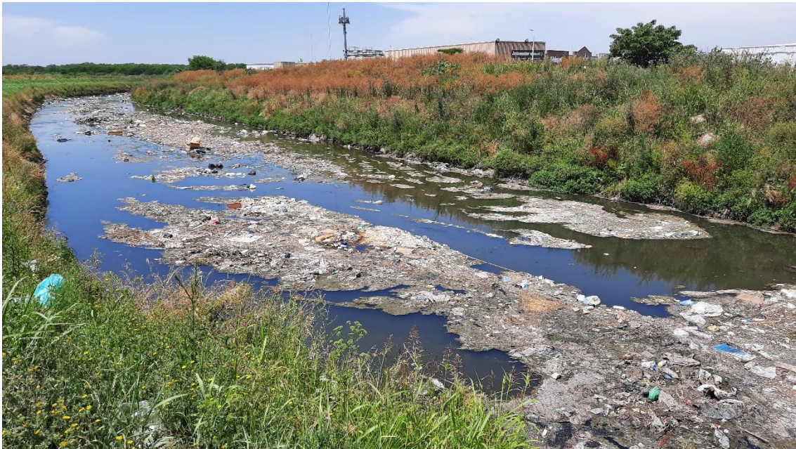
Figura A.18. Vista de la sección de aforo de la EM11 desde aguas arriba hacia aguas abajo. Se observa fuerte presencia de residuos sólidos flotantes que pueden dificultar las campañas de aforo.
