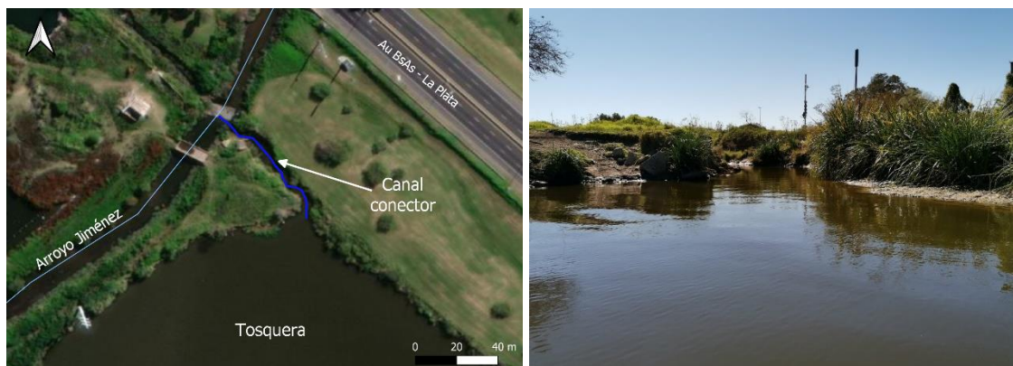
Figura 5.3. Canal de conexión entre la tosquera y el arroyo Jiménez.
