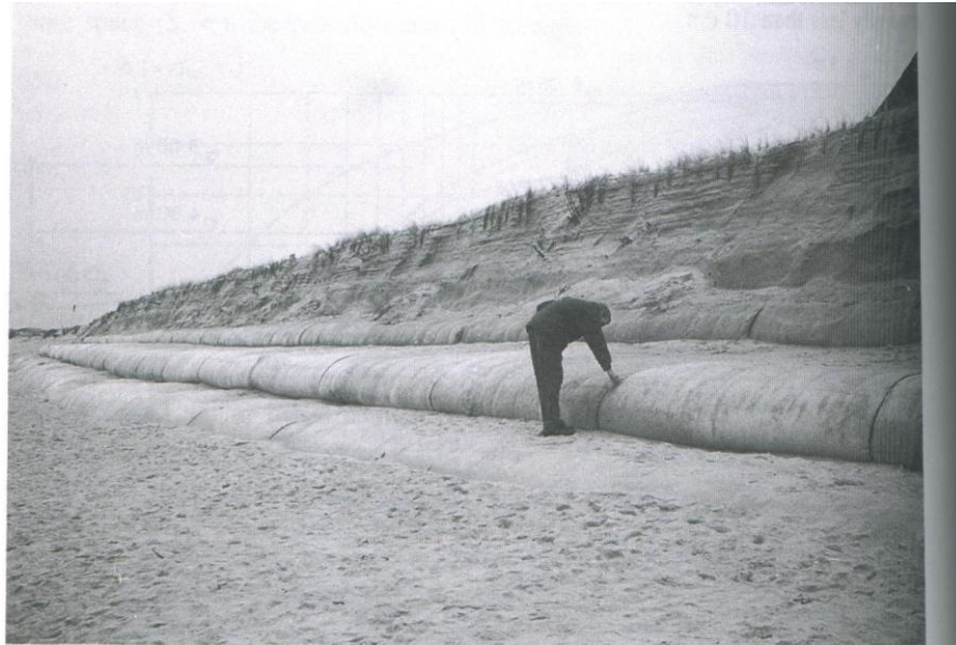
Figura 11.4. Protección de Geotextil
