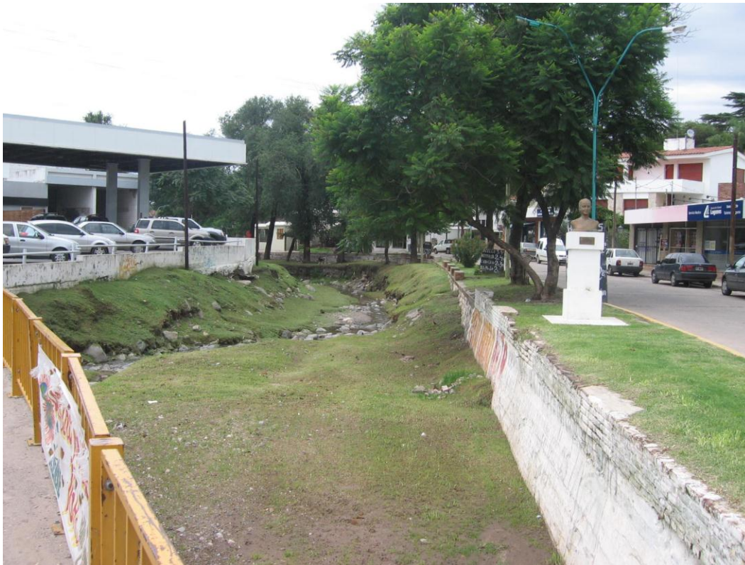
FOTO 1. Desde Av. San Martín. Estación de Servicio y viviendas sobre nivel de terraza inferior inundable ante la ocurrencia de crecientes ordinarias máximas. A° La Ensenadas.
