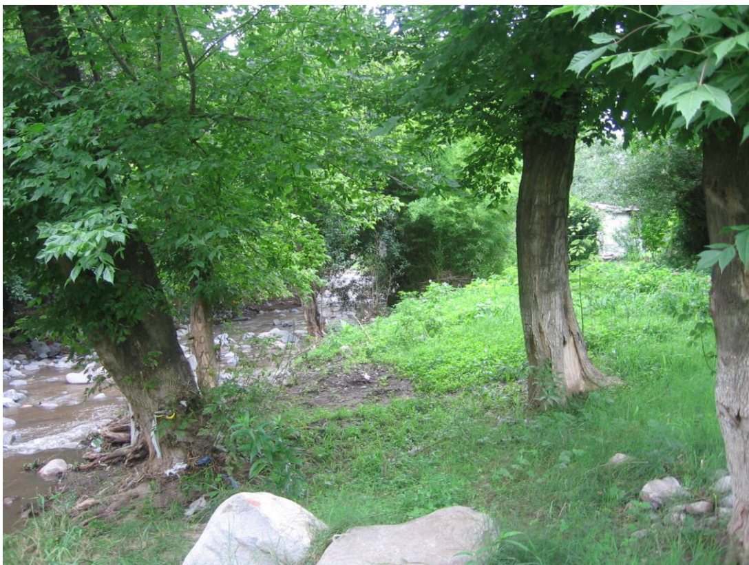
FOTO 11. Idem foto 10. Nuevo trazo de cauce por estrangulamiento. Vivienda a margen derecha con alto riesgo en crecientes ordinarias máximas y severo en crecientes extremas.
