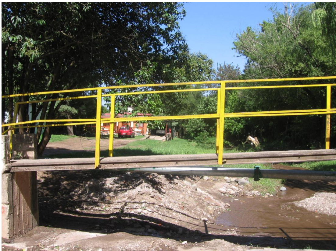
FOTO 7. Pasarela. Calle Colón. Vivienda sobre nivel de terraza inferior inundable en crecientes ordinarias máximas Alto riego en crecientes extremas. Río Ceballos.
