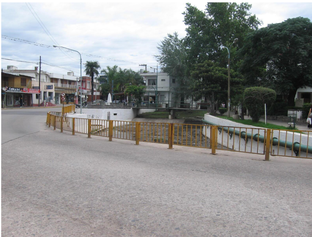
FOTO 2. Puente Av. San Martín. Viviendas a ambas márgenes ocupando el nivel de
