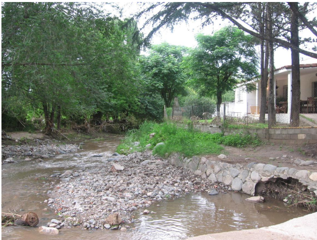
FOTO 9. Vivienda sobre terraza inferior inundable ante la ocurrencia de crecientes ordinarias máximas. Río Unquillo. Alto riesgo en crecientes extremas.
