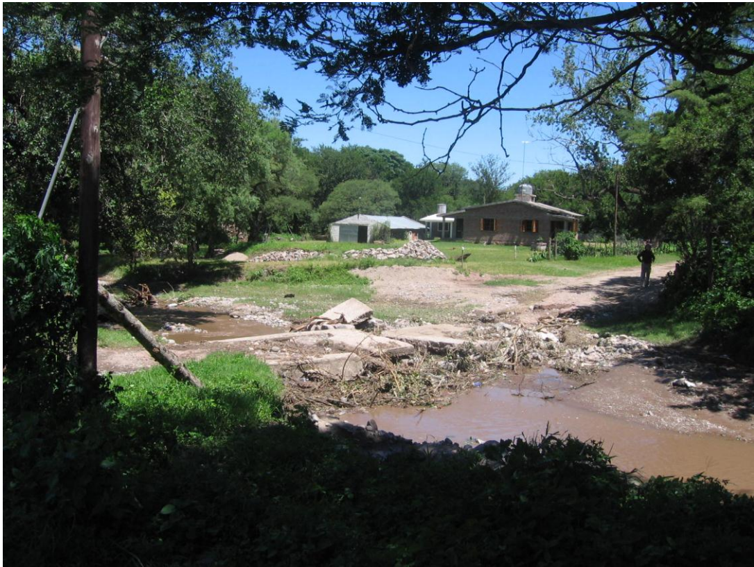
FOTO 13. Vado destruido creciente diciembre 2009. Vivienda en terraza inferior inundable en crecientes ordinarias máximas. Riesgo severo en crecientes extremas. Río Ceballos.
