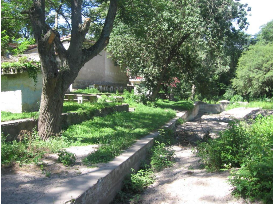
FOTO 17. Complejo en Quebrada Honda. Viviendas ocupando la terraza inferior inmediatamente a la margen del lecho ordinario. Balneario destruido por efecto de crecientes.
